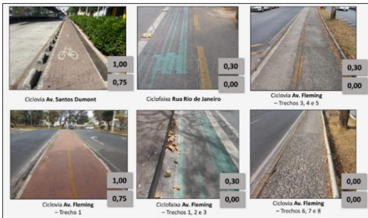
Figura 6.12: Presença e conservação da sinalização horizontal
