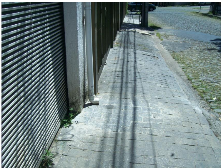
Figura 57 - Vários rebaixamentos de meio fio para acesso a garagem no segmento de calçada 6
