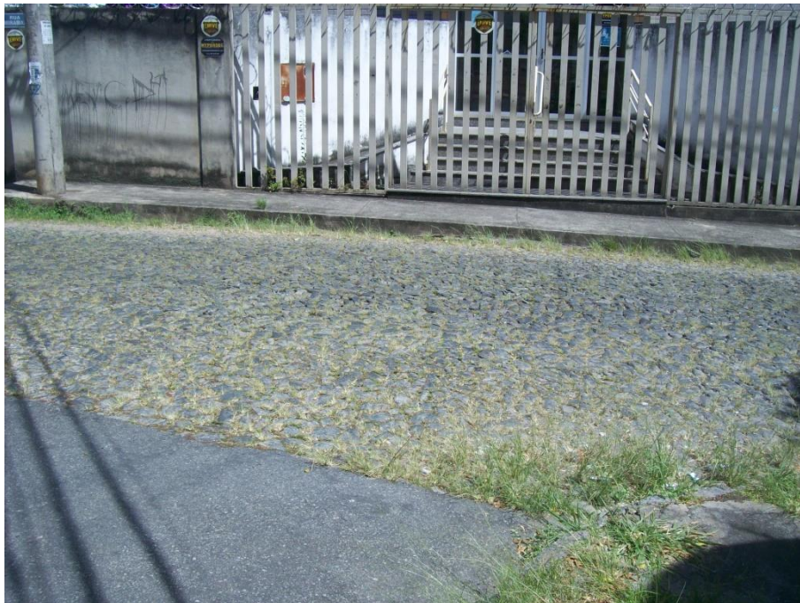
Figura 25 - Travessia no segmento de calçada 5
