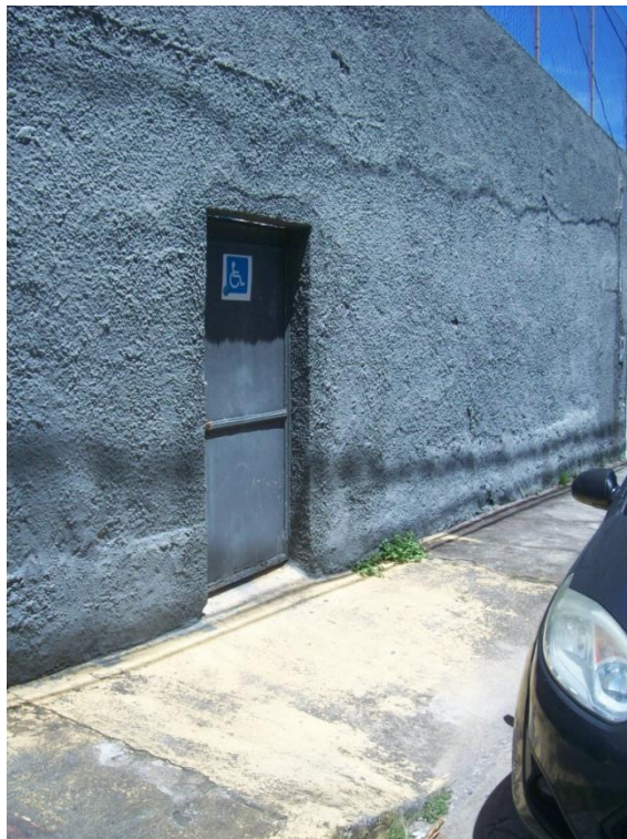
Figura 22 - Entrada acessível do Colégio COPAM BH
