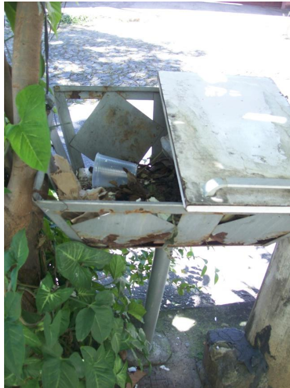
Figura 36 - Lixeira no segmento de calçada 5
