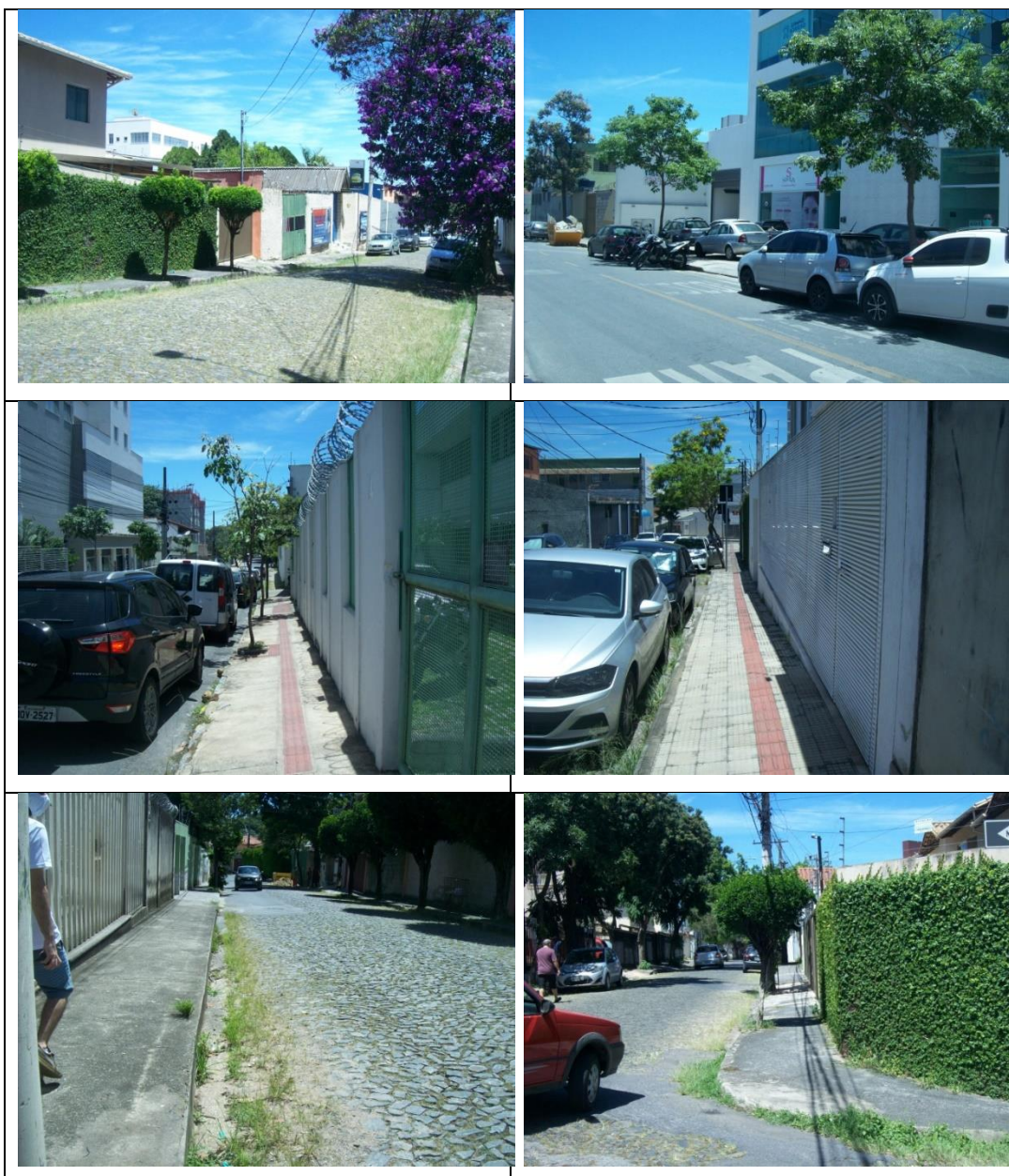
Figura 21 - Segmentos de calçada de 1 a 6
