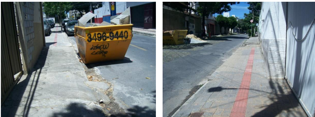
Figura 47 - Sinalização tátil em parte dos segmentos de calçada 2 e 4
