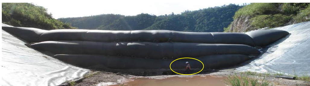
Figura 2.10 Barreira construída com tubos empilhados. Notar altura em relação ao homem (adaptado de TenCate, 2018)
