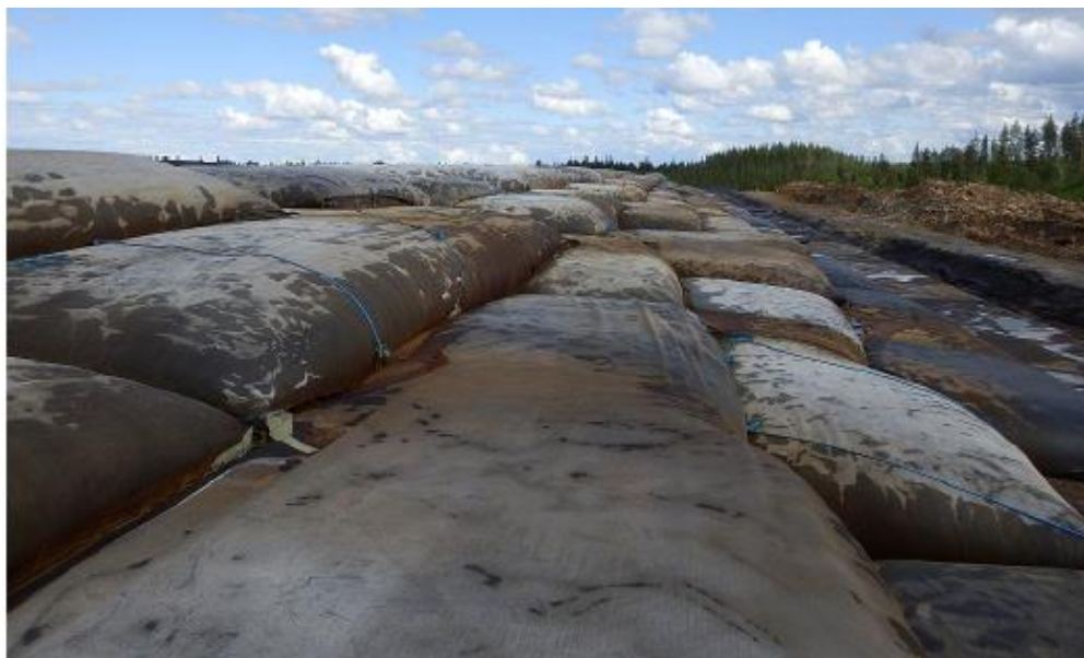
Figura 2.8 – Quinta camada de tubos geotêxteis desaguados
