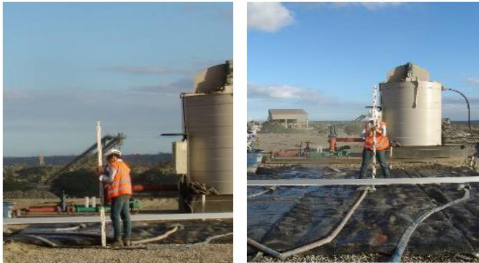
Figura 3.3 – Monitoramento dos deslocamentos verticais feitos por meio da mira a laser e régua em pórtico
