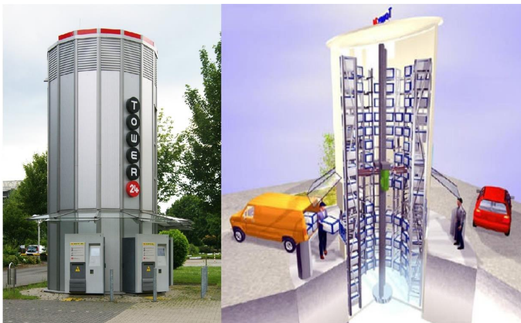
Figura 12 - Foto da Tower24 em Dortmund e esquema de seu funcionamento.
