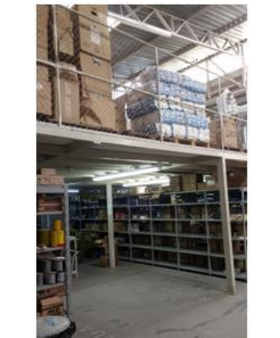
Estrutura Mista de armazenamento em armazém de tintas e EPIs (Q37)
