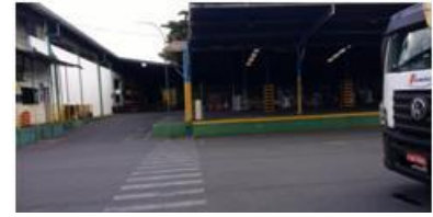
Est. Horizontal de armazenamento (Galpão) em armazém de materiais elétricos (Q35)
