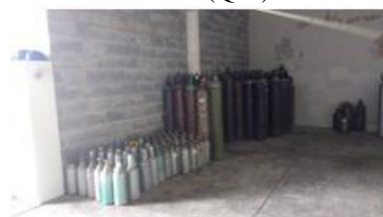
Armazenamento de cilindros de gás em armazém de gases (Q14)
