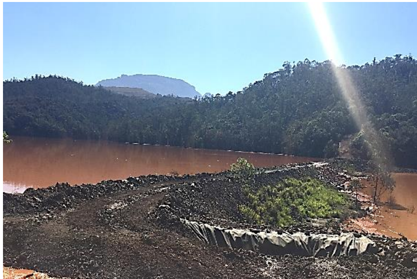
Figura 4.3: Tubos geotêxteis revestidos com camada de cobertura para permitir o acesso de pessoas e veículos.
