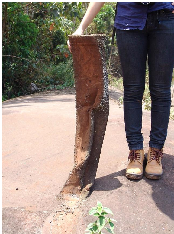
Figura 4.5: Bocal de enchimento dos tubos geotêxteis.
