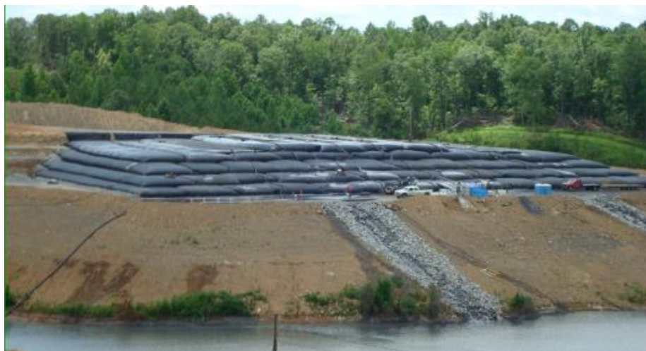
Figura 3.8: Empilhamento final com 4 empilhamentos de tubos geotêxteis. Atenção para o berço de drenagem em enrocamento para direcionamento do efluente para a lagoa (TRAINER, 2009).
