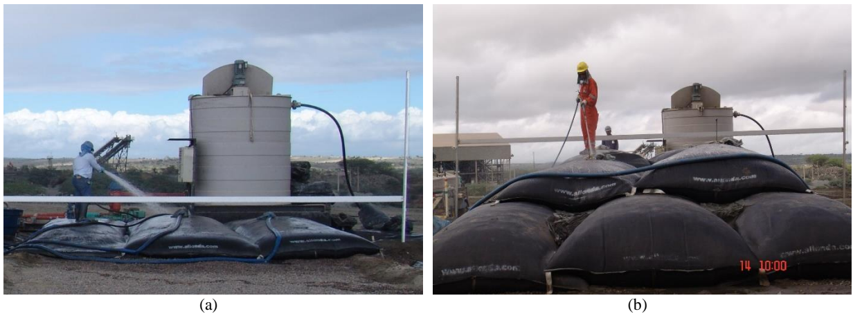
Figura 5.25: Aplicação de hidrojetamento durante o processo de desaguamento.
