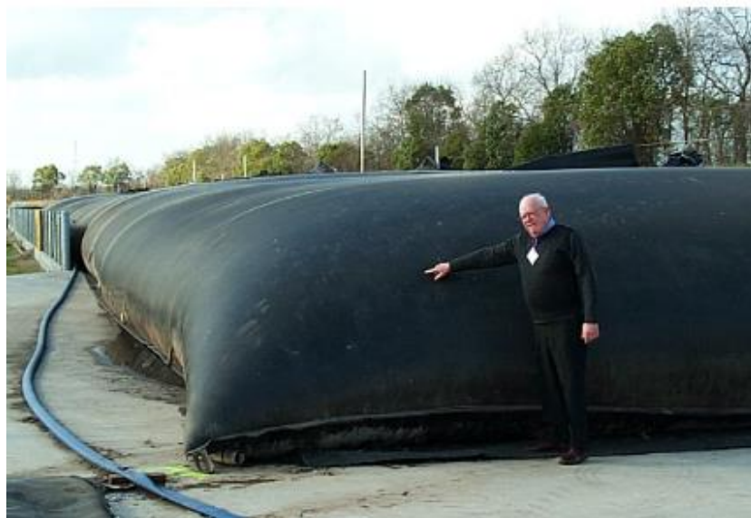
Figura 3.37: Enchimento de tubo em grande escala (adaptado de FOWLER, LARKINS E DUKE, 2005).
