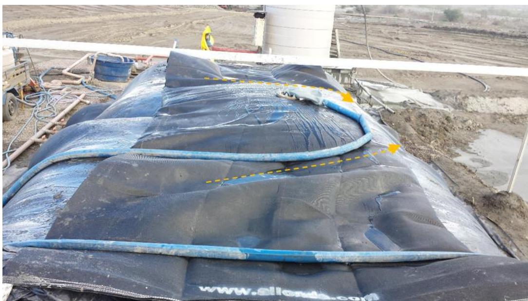
Figura 5.37: Tubo indicando iminência de rolamento.
