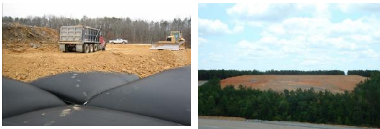
Figura 3.10: Em (a) processo de recuperação da área com cobertura de solo e em (b) configuração final da área recuperada (b) (TRAINER, 2009).
