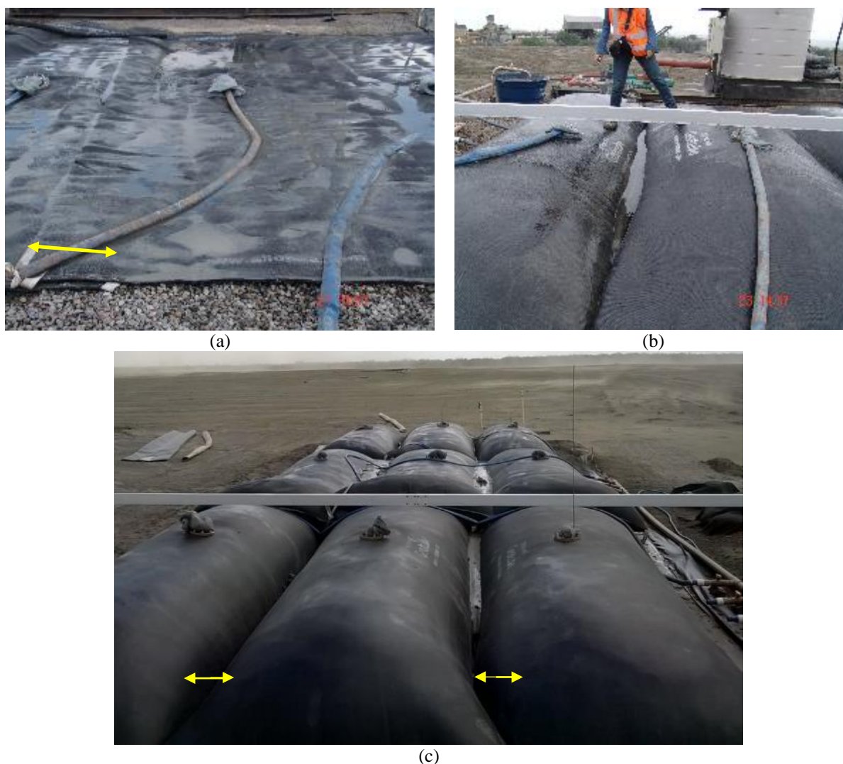
Figura 5.27: Em (a) transpasse de 20 cm na disposição inicial dos tubos; em (b) deslocamento horizontal entre os tubos em etapa intermediária; em (c) tubos já sem contato lateral.
