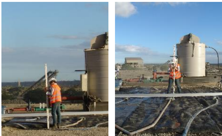
Figura 4.27: Monitoramento dos deslocamentos verticais do tubo geotêxtil a partir da mira-laser.
