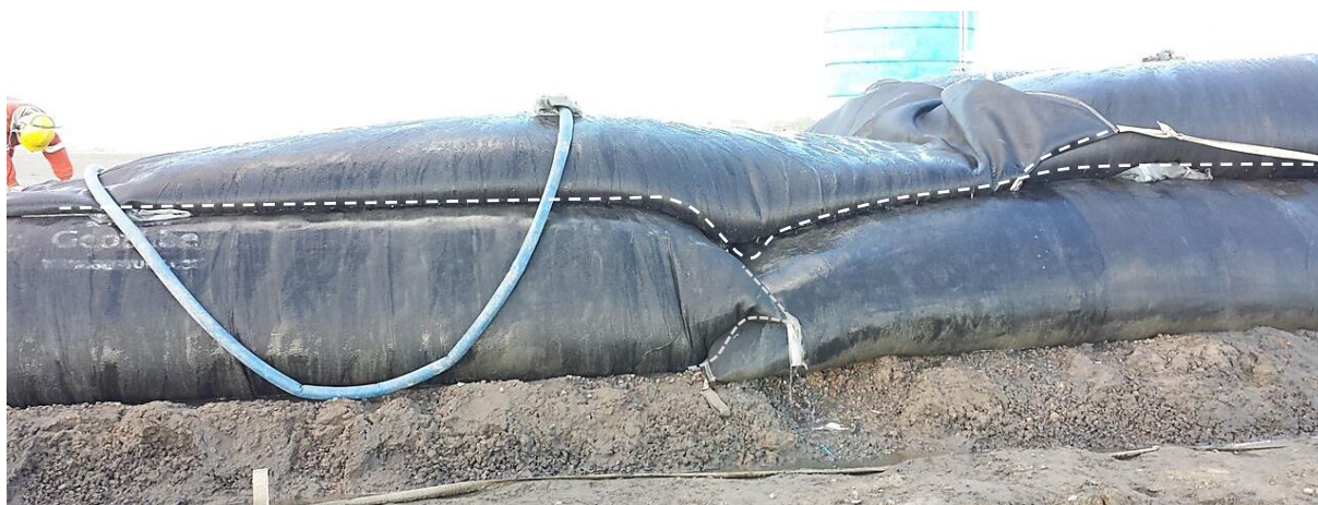
Figura 5.36: Deformações no tubo geotêxtil durante enchimento no empilhamento.
