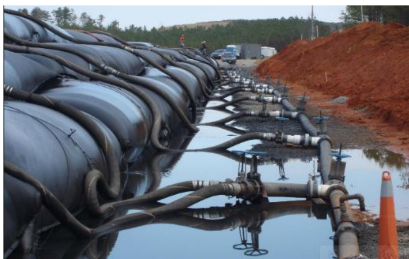
Figura 3.9: Sistema de bombeamento para enchimento simultâneo dos tubos geotêxteis (TRAINER, 2009).
