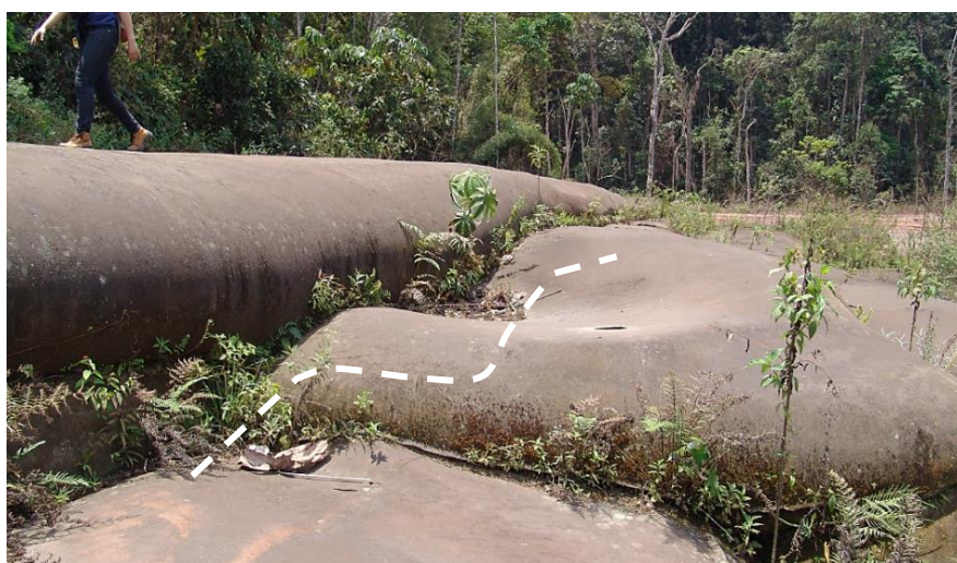
Figura 4.8: Deformação na região de contato e superposição de tubos geotêxteis.
