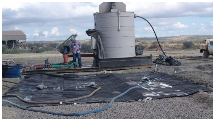
Figura 5.17: Disposição dos tubos geotêxteis sob a base drenante de ensaio. Detalhe para a superposição do tubo central sob os laterais.
