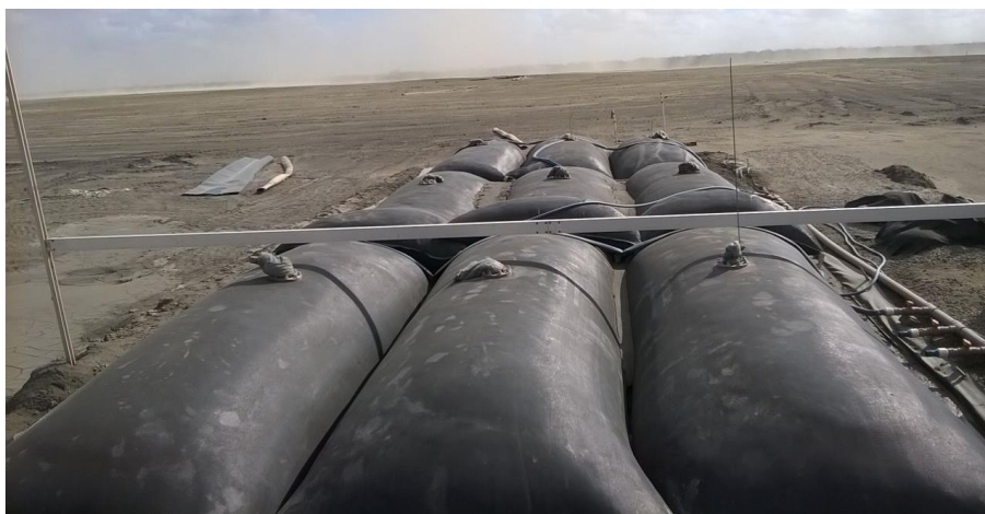
Figura 5.32: Primeira fase de enchimento e base do empilhamento com tubos geotêxteis.
