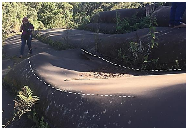
Figura 4.7: Deformações ao longo de tubo geotêxtil.
