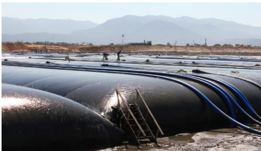
Figura 3.4: Confinamento e desaguamento de material contaminado dragado do canal do Porto de Santos (CARVALHO, 2013).
