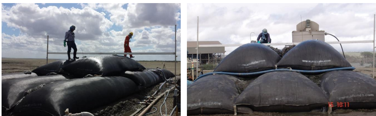
Figura 5.33: Primeira fase de empilhamento dos tubos geotêxteis.
