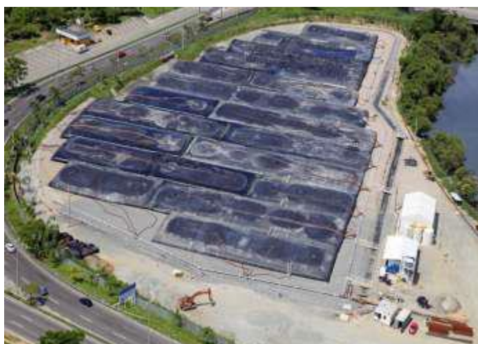
Figura 3.3: Uso de tubos geotêxteis para a retirada de material contaminado no canal de Fundação, no Rio de Janeiro (STEPHEN ET AL, 2009).
