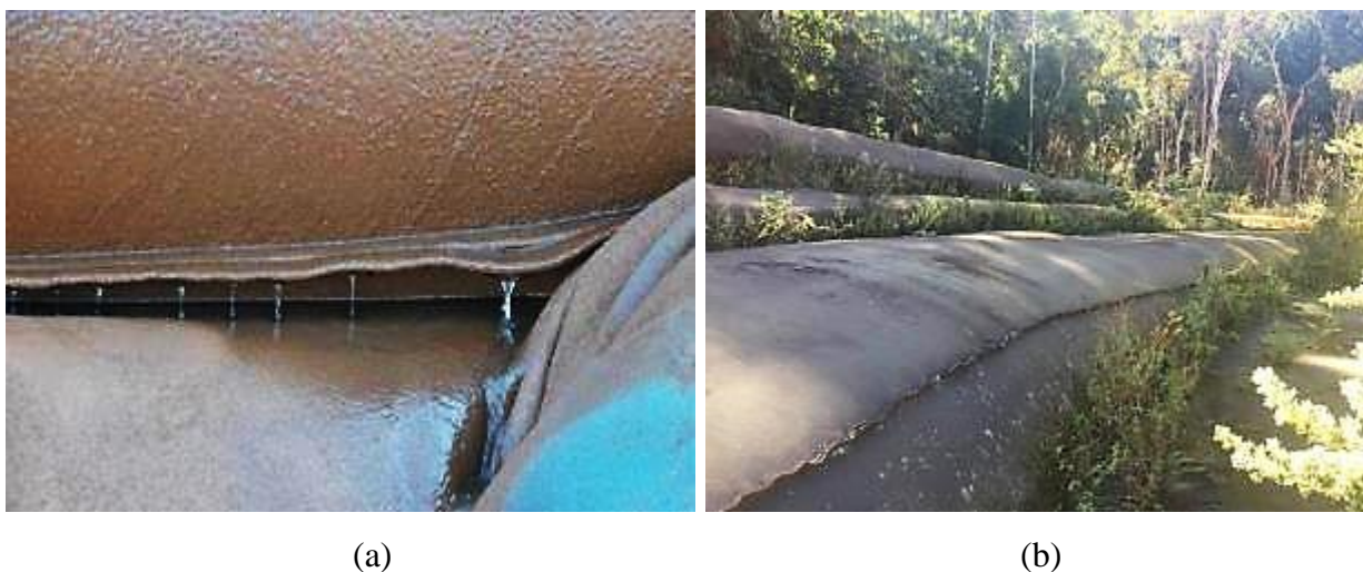
Figura 1.1: Vistas de tubos empilhados: (a) desaguamento do tubo geotêxtil durante enchimento (OBER, 2013); (b) condições do tubo de geotêxtil após desaguamento e adensamento do rejeito.
