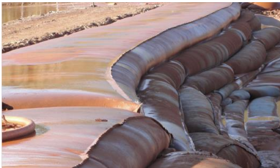
Figura 4.2: Empilhamento de tubos de geotêxteis não tecidos logo após enchimento (OBER GEOSINTÉTICOS, 2013).
