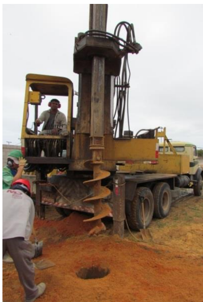
Figura 2.1: Equipamento de estaca trado mecanizado sobre chassi de caminhão
