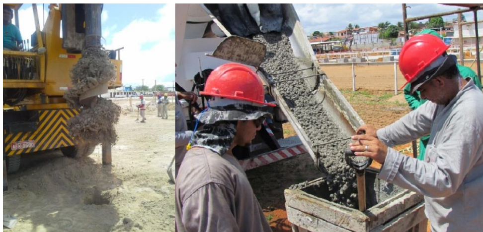
Figura 3.7: Escavação com trado mecanizado e concretagem com funil
