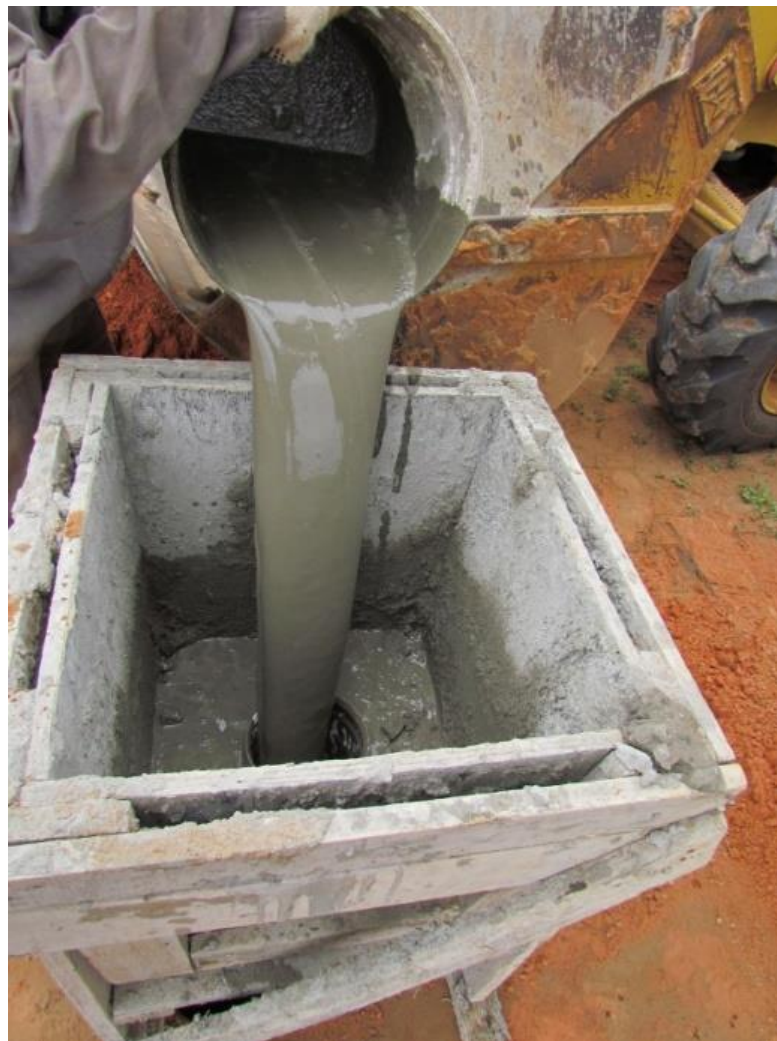
Figura 3.11: Lançamento da argamassa com auxílio do funil
