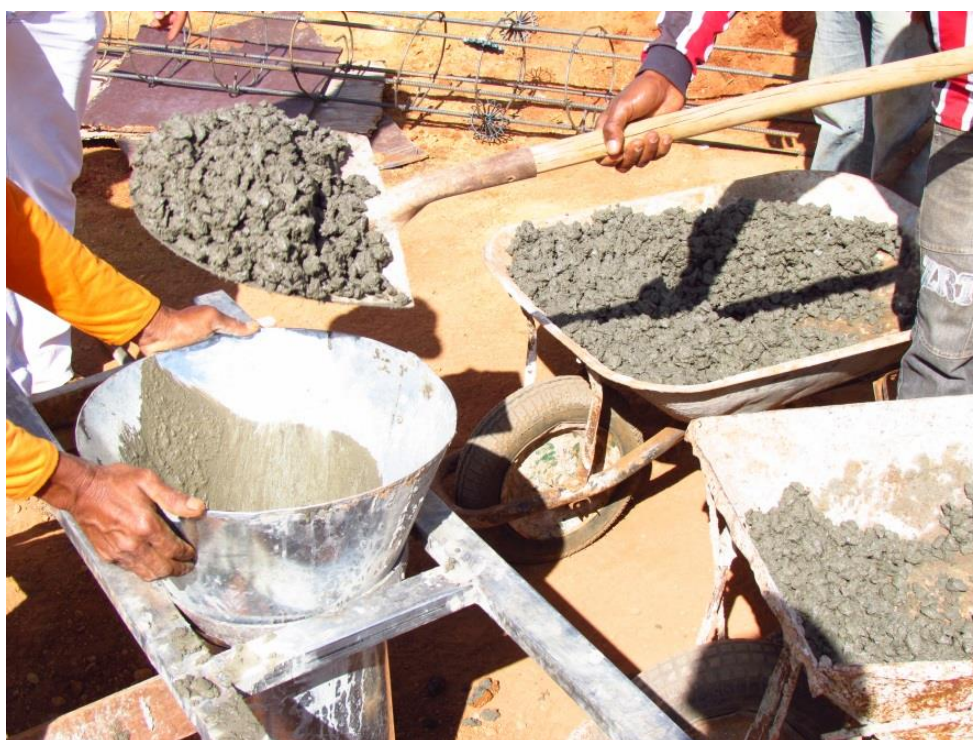
Figura 3.14: Adição de bucha de concreto sobre o solo solto na ponta da estaca
