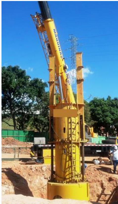
Figura 2.16: Instalação de martelo hidráulico para execução do ensaio
