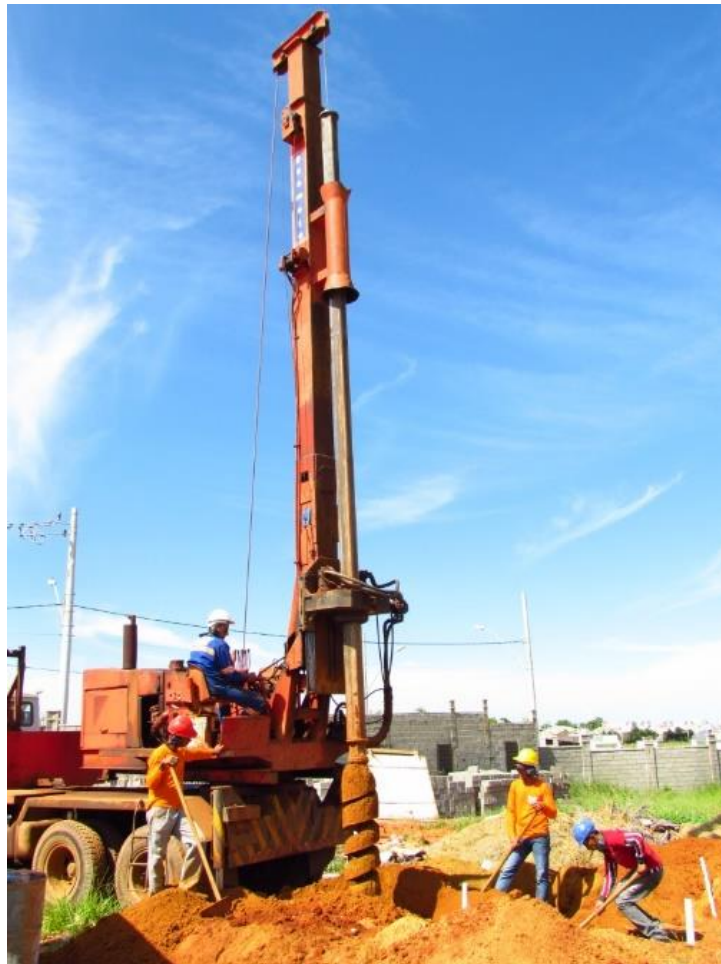
Figura 3.2: Equipamento trado mecanizado montado sobre caminhão
