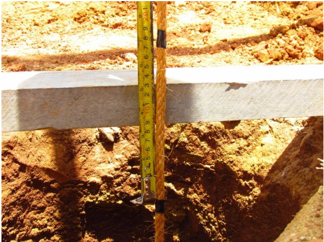
Figura 3.10: Medição da nega
