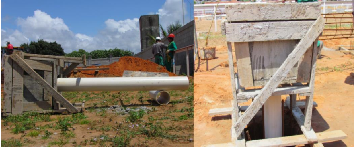
Figura 3.4: Funil utilizado para lançamento dos materiais.
