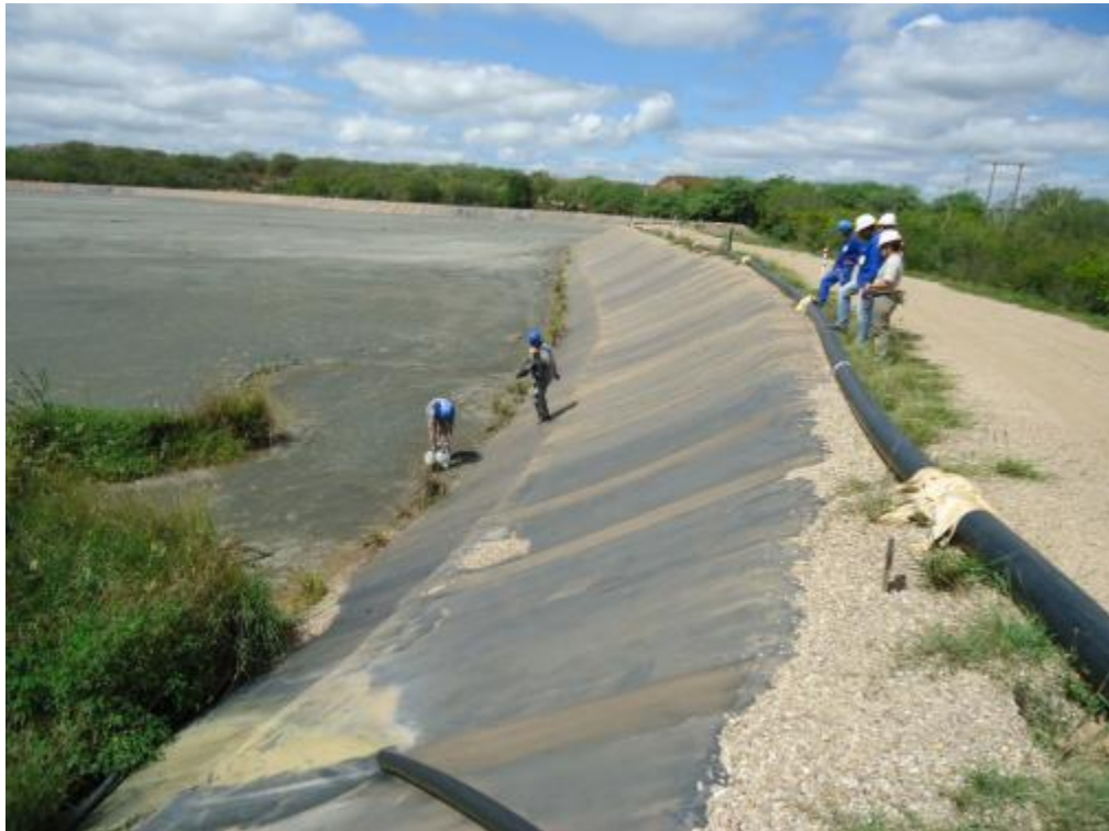
Figura 3-20 – Lago III – Vista da GM de PVC instalada
