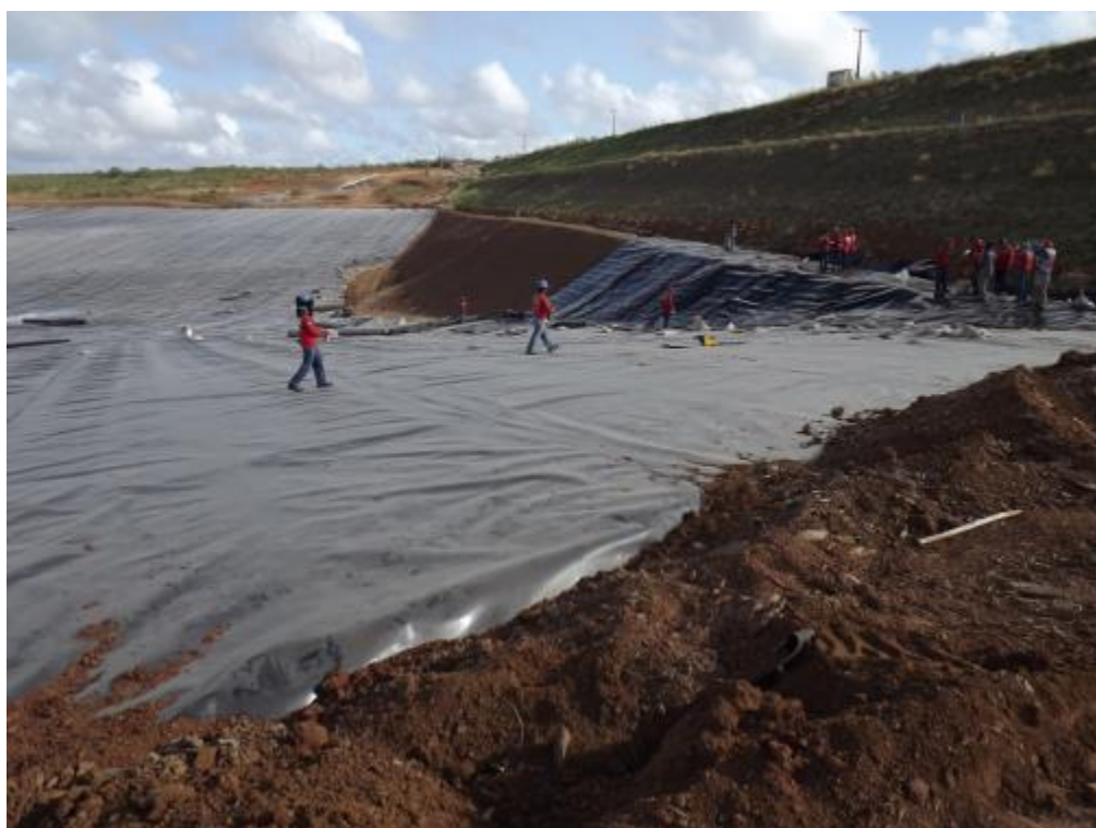
Figura 3-14 – Dique de segurança – Instalação da geomembrana de HDPE
