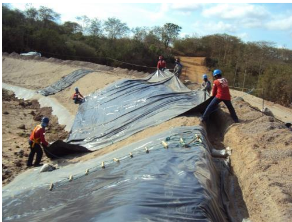
Figura 3-17 – Lago III – Detalhe da colocação da GM de PVC sobre o talude
