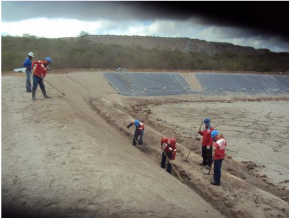
Figura 3-19 – Lago III – Acabamento do talude antes da colocação da GM de PVC
