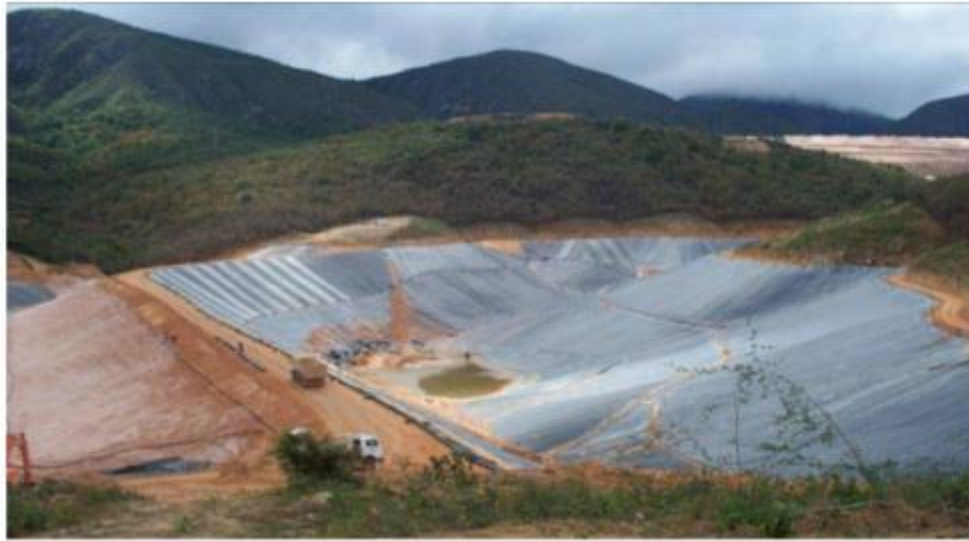
Figura 3-22 – Vista geral da barragem de Jacobina 1ª etapa (DAM, 2010 apud SAMPAIO, 2013).
