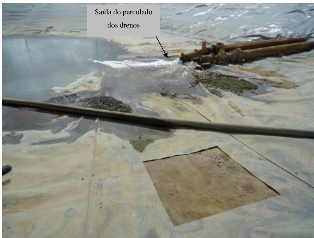
Figura 3-16 – Dique de segurança – Exumação de amostra –Nota-se a saída do percolado de cianeto dos drenos de fundo do Lago II
