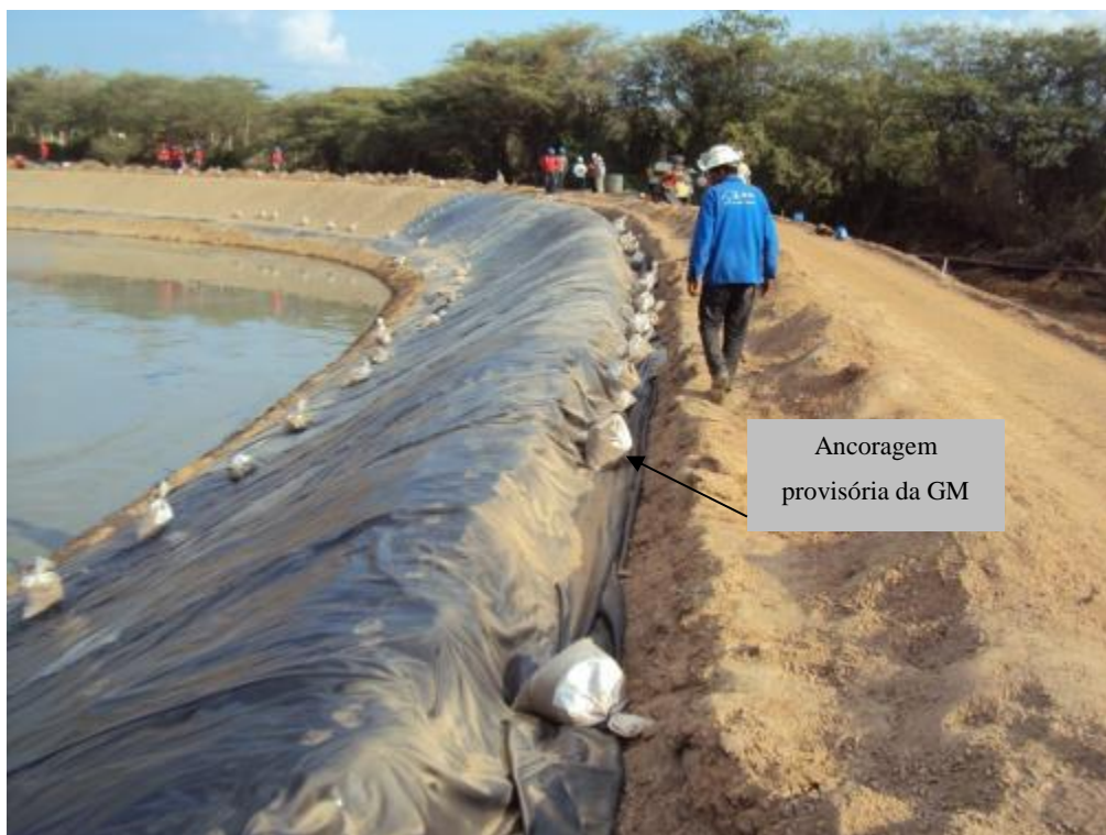
Figura 3-18 – Lago III – Detalhe da ancoragem provisória para instalação (GM de PVC)
