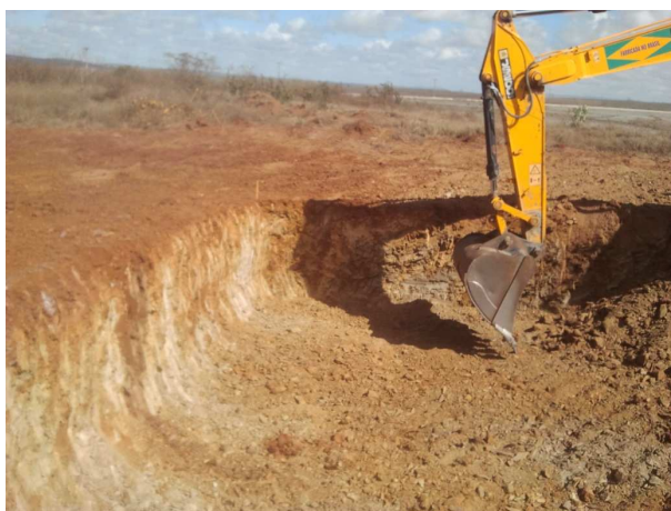
Figura 3.14 - Escavação de bacia
