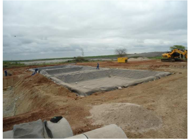
Figura 3.15 - Impermeabilização dos experimentos com geomembrana.
