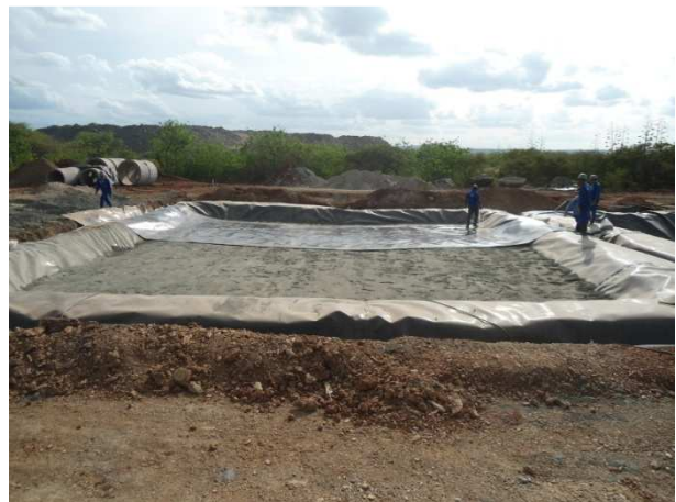
Figura 3.16 - Detalhes de instalação da geomembrana entre a barreira capilar e o rejeito
