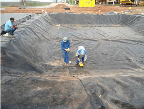
Figura 3.15 - Impermeabilização dos experimentos com geomembrana.
