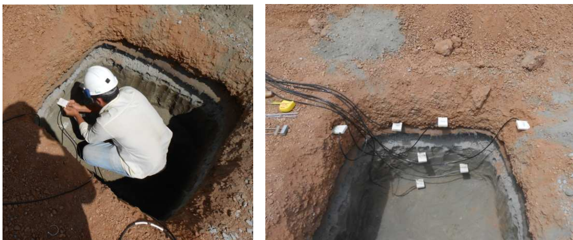
Figura 3.17 - Instalação dos sensores de umidade.
