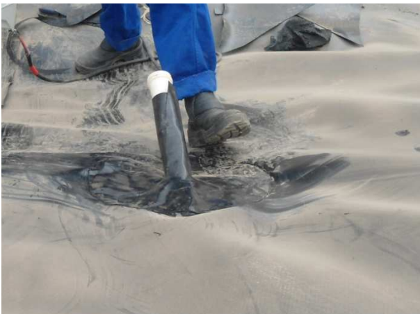
Figura 3.16 - Detalhes de instalação da geomembrana entre a barreira capilar e o rejeito
