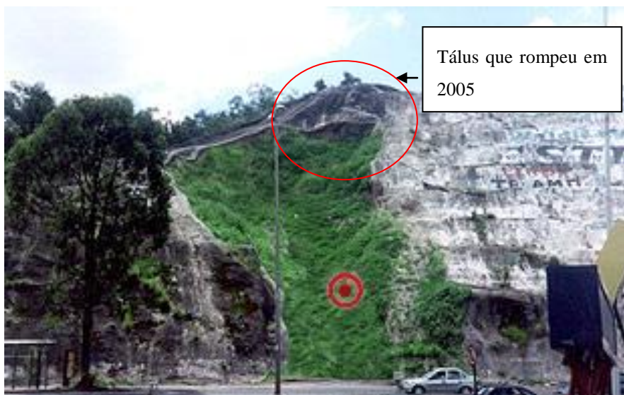
FIGURA 4.2- Vista do Talude Ponteio em 2003 (Fonte site www.deflor.com.br )
