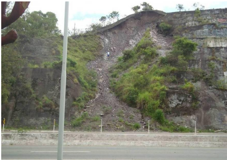
FIGURA 4.4 - Vista do Talude Ponteio em 2010
