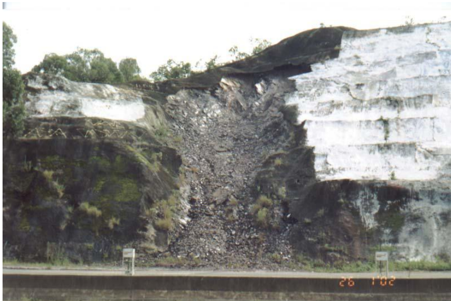
FIGURA 4.1- Vista do Talude Ponteio em 2002 (Parizzi, 2004)
