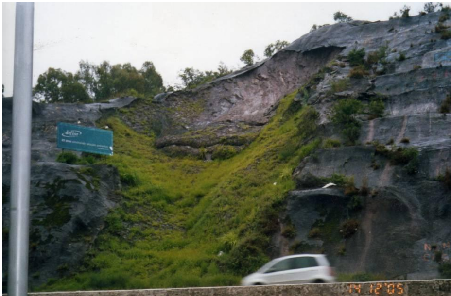
FIGURA 4.3- Vista da tela metálica antes de romper, sofrendo a pressão do tálus (acervo pessoal Parizzi)
