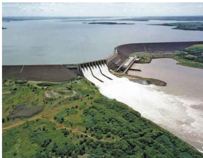
FIGURA 4.19 – Usina Hidrelétrica de São Simão
