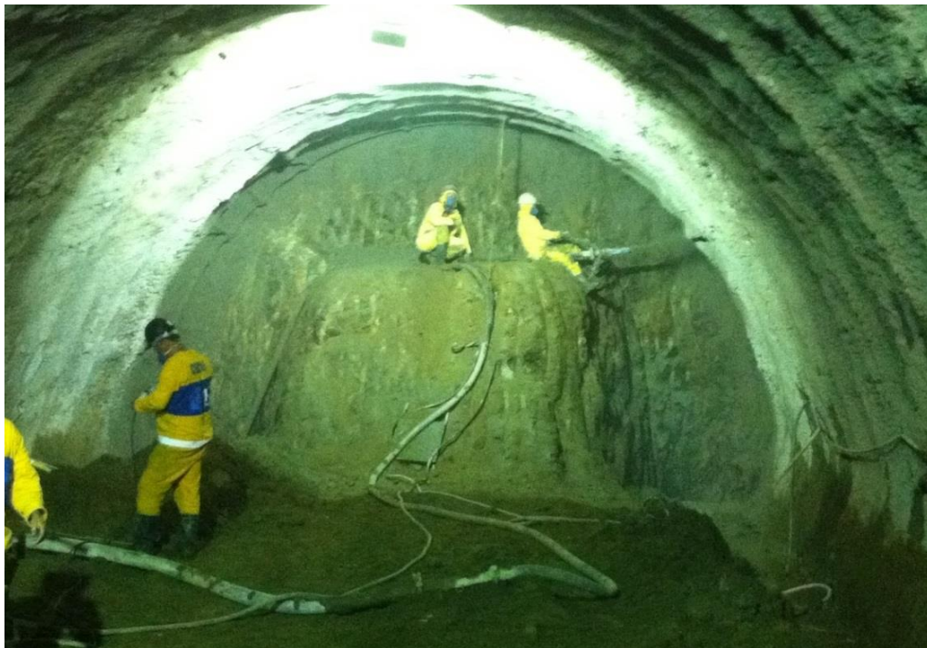
FIGURA 4.9 - Foto – Projeção do concreto – Detalhe do muro de suporte da face
