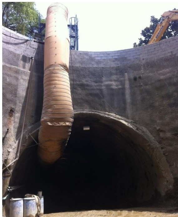
FIGURA 4.12 - Túnel de Desvio do Rio Joana detalhe do emboque do túnel – Poço “A”
