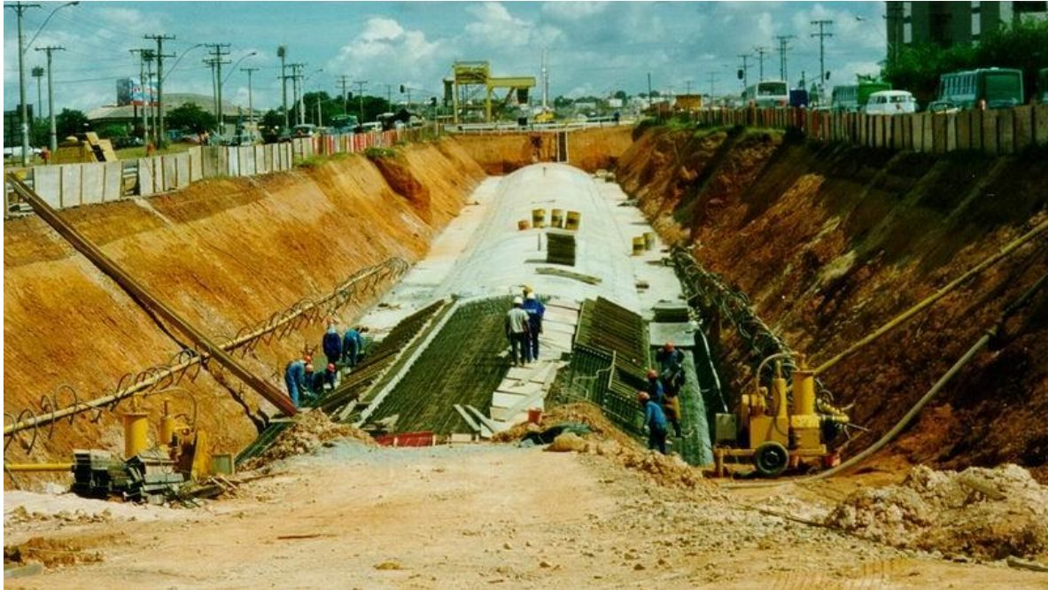
FIGURA 2.3 - Método de construção a céu aberto. Metrô de Brasília-DF (Assis, 2013)
