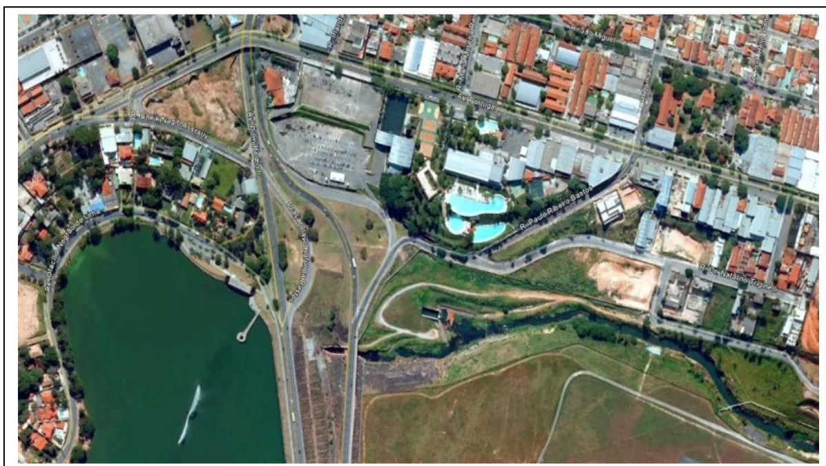
FIGURA 38 - Vista aérea da localização da Estação Pampulha Fonte: TECNOTRAN; OFICINA, 2012.
