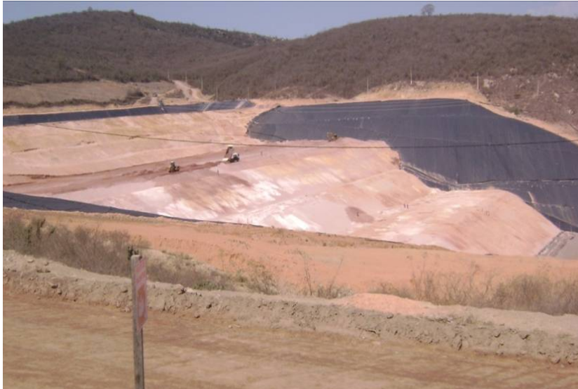
FIGURA 3.15 – Vista do talude de jusante da barragem 2ª etapa.
