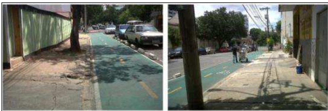
Figura 45 – Árvore ocupa parte da calçada.
