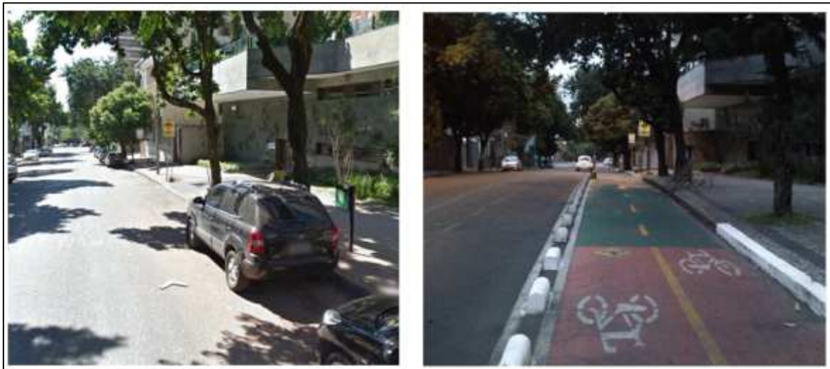
Figura 52 – Rua Piauí antes e após a implantação da ciclovia.
