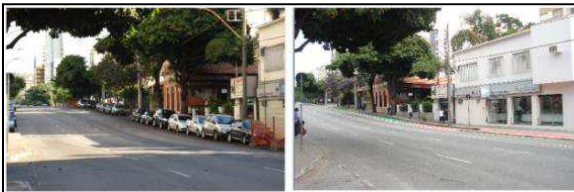
Figura 36 – Rua Professor Moraes sem a ciclovia e com as obras em andamento.
