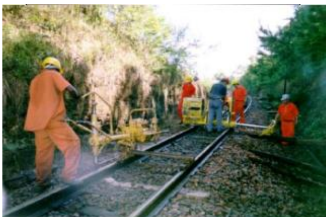
FIGURA 3.14 - Retirada mecanizada de fixação. (FONTE- ANTF, 2010)
