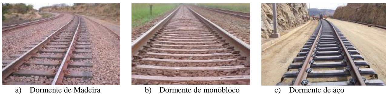
FIGURA 3.5 - Tipos de dormentes existentes. (FONTE – AAR, 2010)
