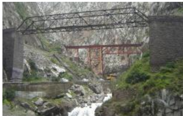
FIGURA 3.27 –Intervenção em obra de arte especial. (FONTE - ANTF, 2009).
