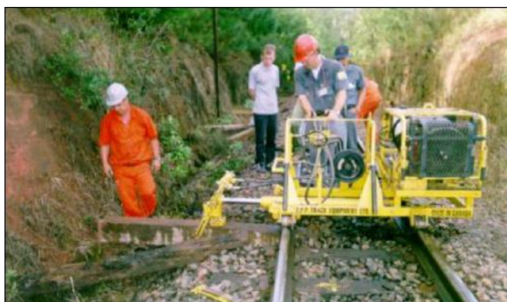
FIGURA 3.15 – Troca mecanizada de dormentes. (FONTE-ANTF, 2010)
