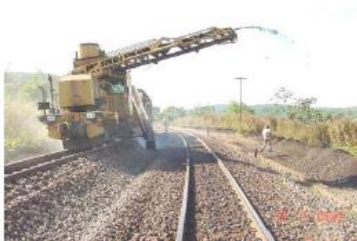
FIGURA 3.17 – Desguarnecimento mecanizado de lastro. (FONTE-ANTF, 2010)
