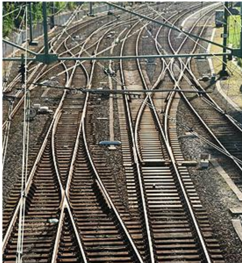
FIGURA 3.2 - AMV Aparelho de Mudança de Via (FONTE – AAR, 2012)
