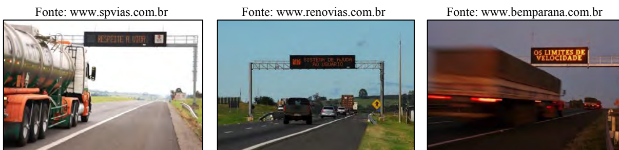
Figura 3 – Exemplos de painéis de mensagens variáveis em rodovias concedidas
