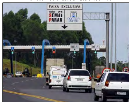
Figura 30 – Pórtico de cobrança do “Ponto a Ponto” e uma praça com faixa exclusiva
