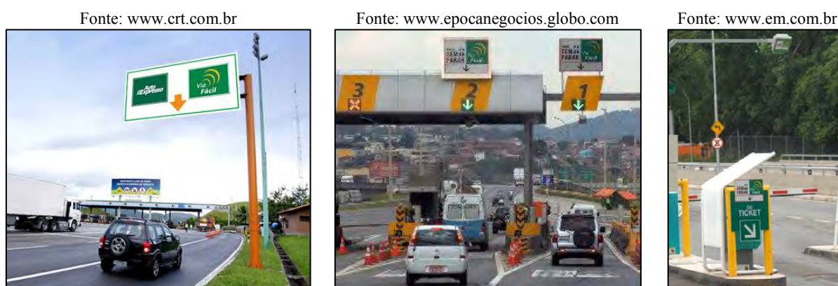
Figura 23 – Exemplos de pontos de cobrança eletrônica por AVI no país
