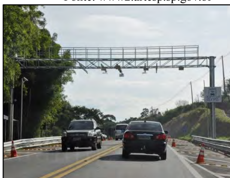
Figura 30 – Pórtico de cobrança do “Ponto a Ponto” e uma praça com faixa exclusiva
