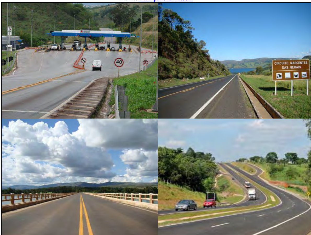
Figura 32 – Trechos da MG-050
