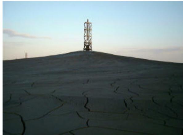
(b) Disposição progressiva formando um cone.
