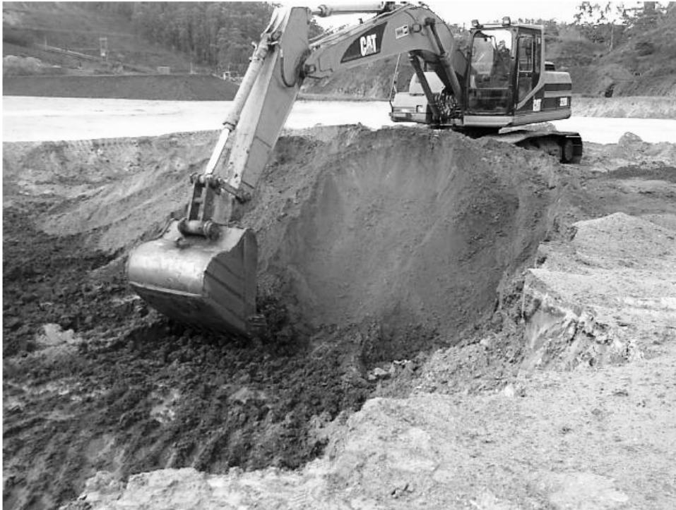
FIGURA 2.8 – Camada de rejeito, disposto como empilhamento drenado, sendo escavado (Fonte – Pimenta, 2011)
