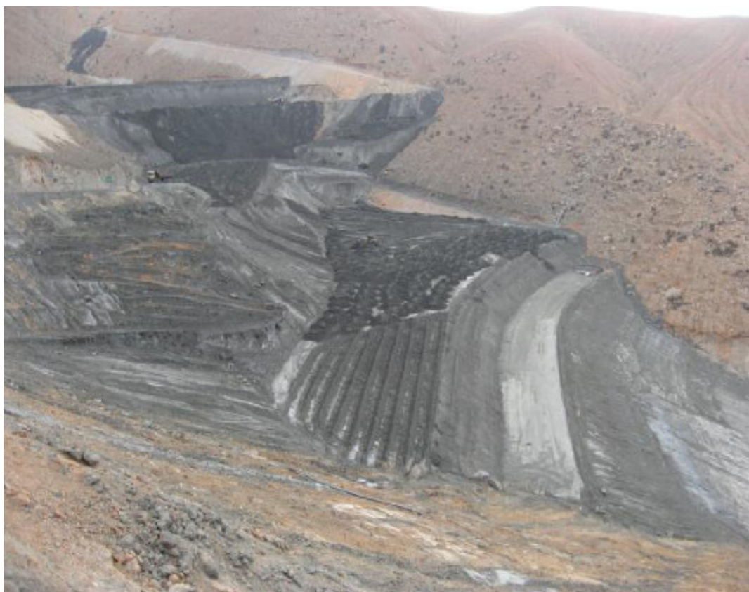
FIGURA 2.27 – Operação em dry stack de Cerro Lindo (Fonte: Lara e León, 2011)
