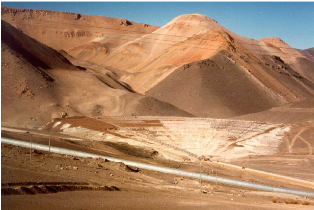
FIGURA 2.26 – Operação em dry stack de La Coipa (Fonte: Davies, 2004)
