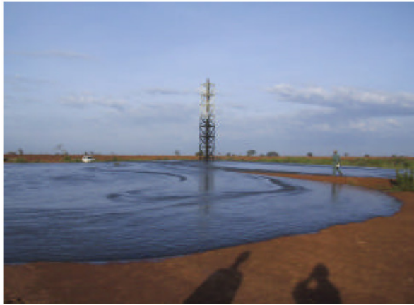
(a) Início da disposição por torres.
