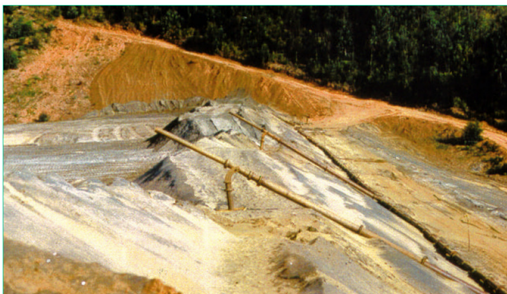
FIGURA 2.6 – Disposição de rejeitos através do método de aterro hidráulico (Fonte – Espósito, 2000)
