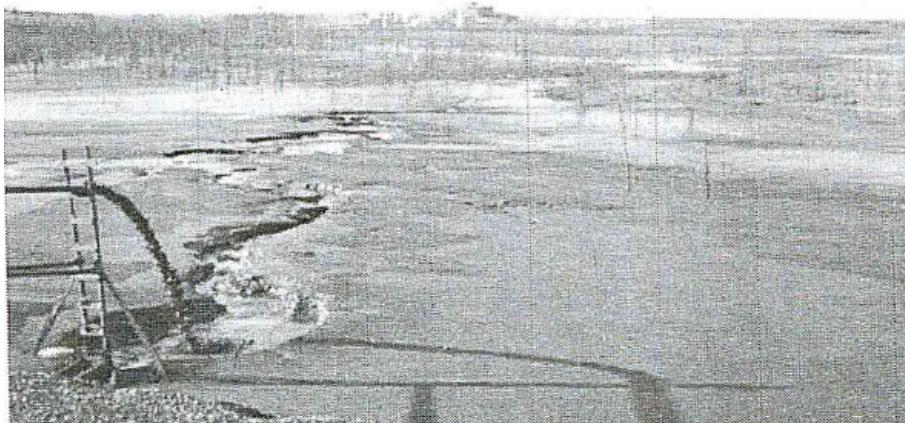
FIGURA 2.19 – Erosão laminar em um depósito de rejeitos espessados (Fonte: Robinsky, 1999)
