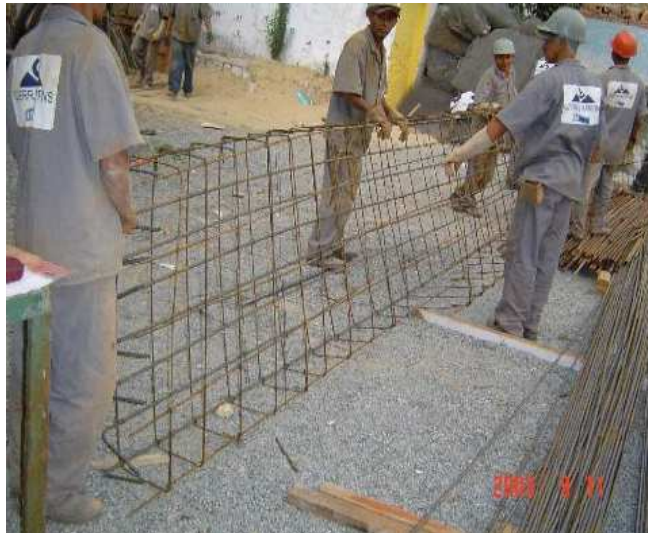
Figura 3.13 - Montagem e transporte da armadura (Velloso Filho, 2009)
