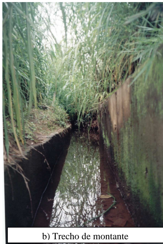
Figura 3.38 - Obstrução da calha de drenagem e coleta pluvial – trechos de jusante e montante
