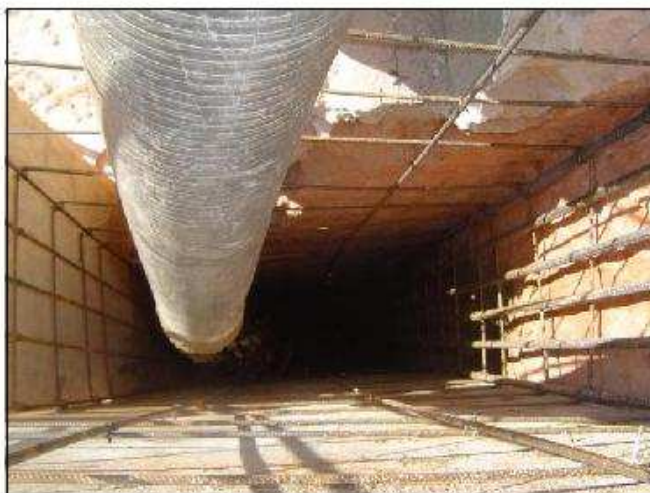
a) Concretagem utilizando lançamento com tromba
