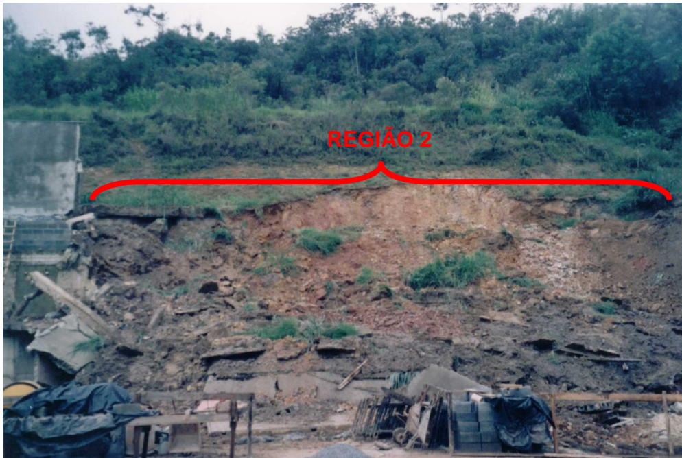
Figura 3.32 - Vista frontal da ruptura ocorrida em 07/01/2003
