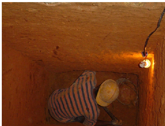
Figura 3.8 - Escavação manual de retangulão (Velloso Filho, 2009)
