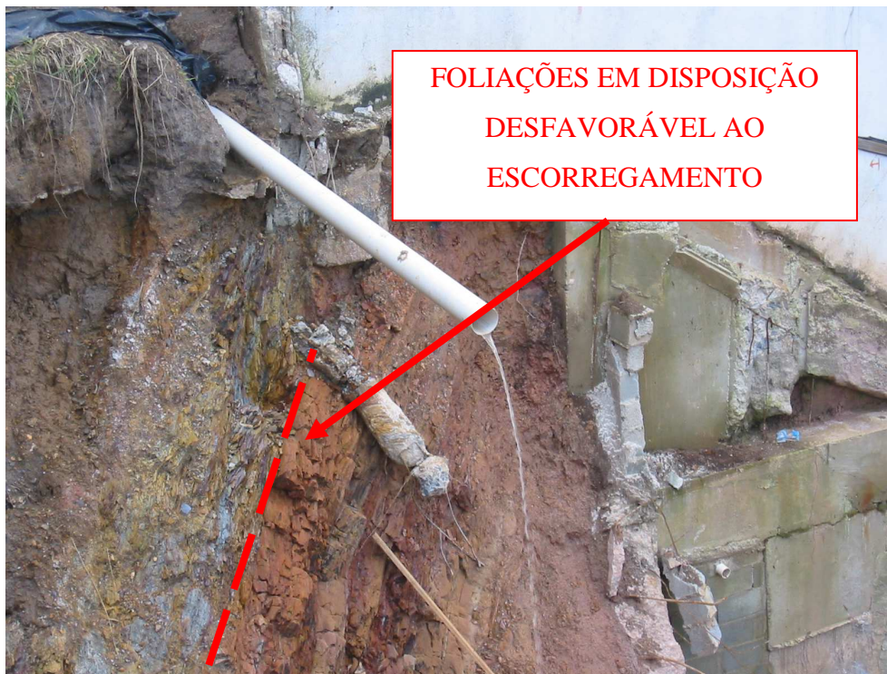
Figura 3.41 - Exumação do perfil residual com ênfase na posição das foliações
