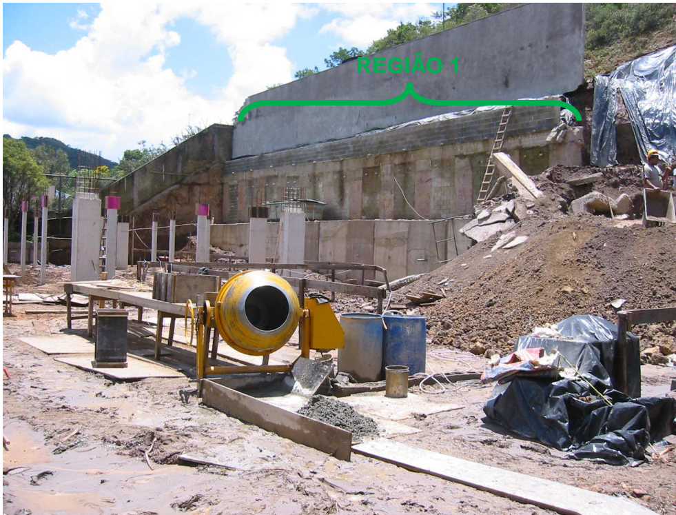
Figura 3.36 - Vista da região "1" da contenção não estabilizada
