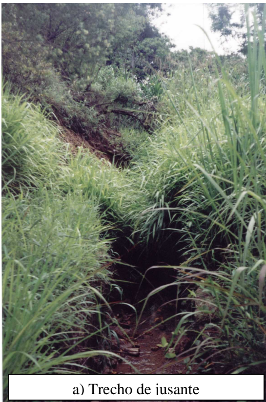
Figura 3.38 - Obstrução da calha de drenagem e coleta pluvial – trechos de jusante e montante
