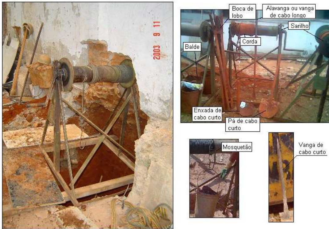
Figura 3.9 - Ferramental para execução de retângulos (Velloso Filho, 2009)
