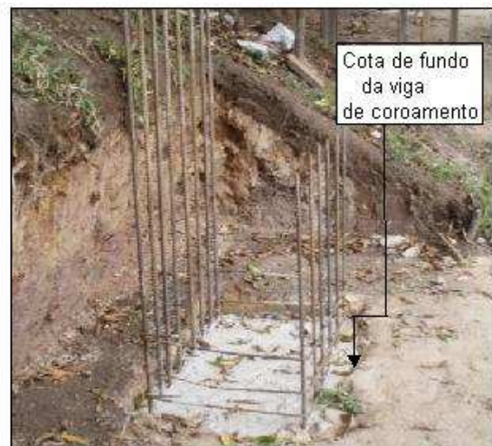
b) Detalhe da cabeça do retângulo concretado
