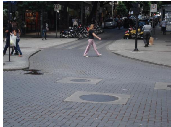
Figura 96 - Piso elevado da interseção das ruas dos Tamoios e Rio de Janeiro
