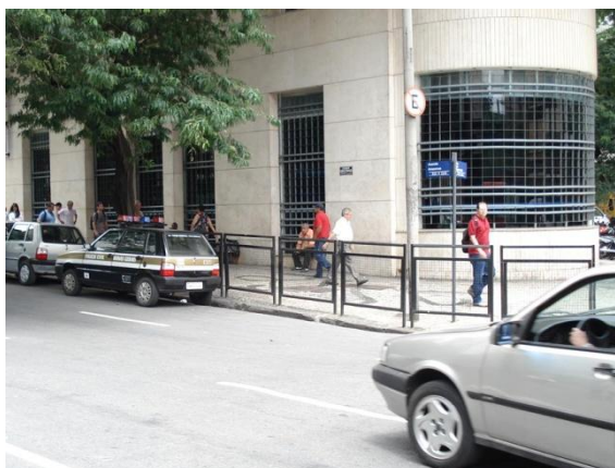
Figura 134 - Gradil na Av. Amazonas
