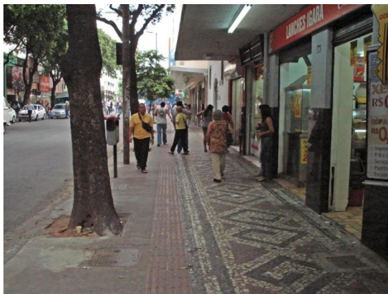
Figura 207 - Proteção contra o tráfego oferecida pela arborização e mobiliário urbano na Rua dos Tamoios
