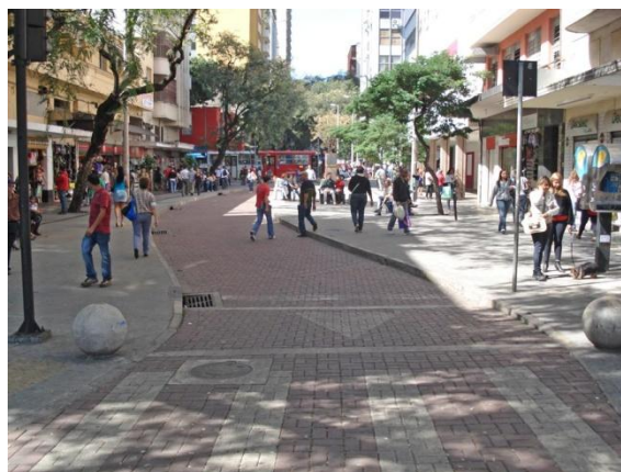
Figura 70 - Rua dos Carijós, trecho 5
