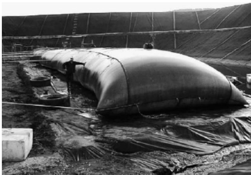
Figura 2.28 - Desaguamento de rejeito de mineração em tubos de geotêxteis (VIDAL e MARTINS, 2006)
