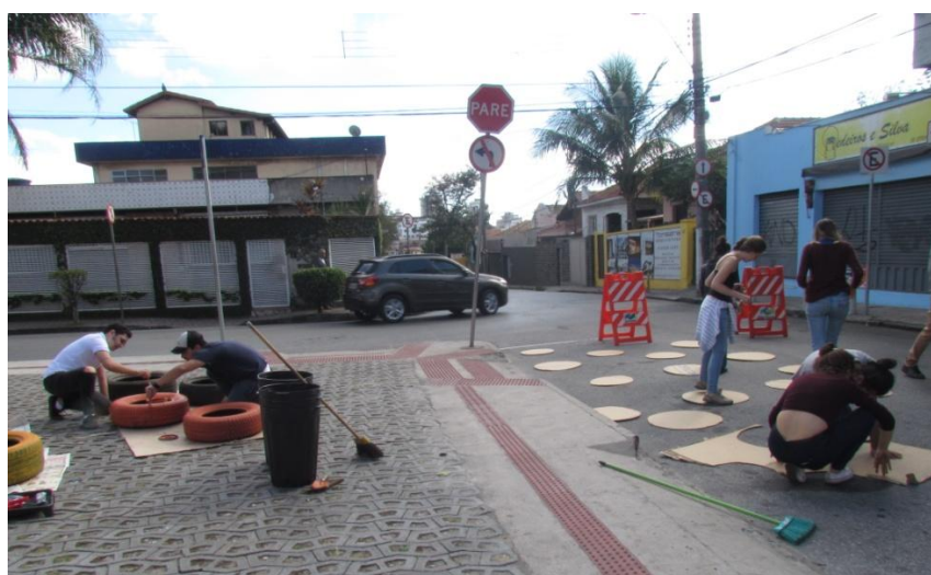
Figura 72 – Início dos trabalhos de transformação da Área Alvo 2
