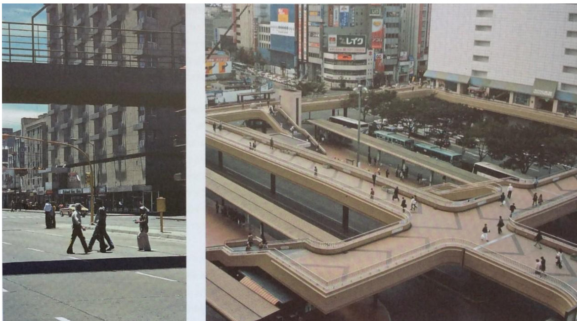
Figura 18 – Ilustra-se, à esquerda, pedestres ignorando a travessia por uma passarela e, à direita, uma complexa rede suspensa para a circulação pedonal Fonte: Gehl (2013a)
