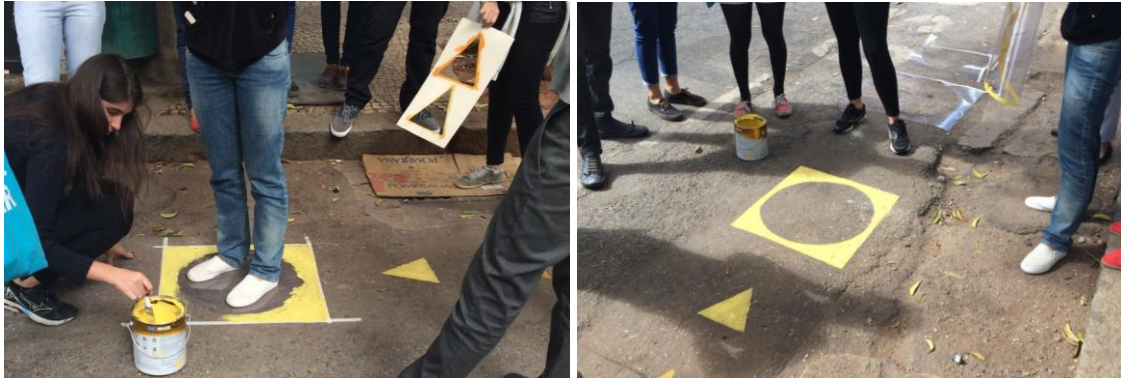
Figura 53 – Testes de tintas e moldes: técnica de pintura stencil sobre o asfalto
