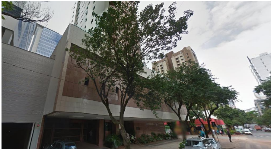
Figura 11 – Solução construtiva em “bandeja” ocupada por estacionamento Fonte: Google Street View (19/09/2016)
