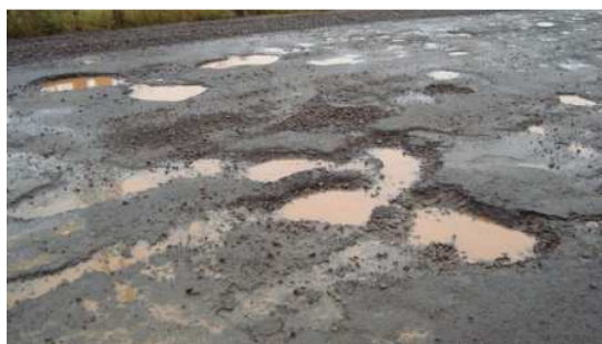
Figura 6.5 - Condição B: situação de impossibilidade para a contagem dos buracos na via
