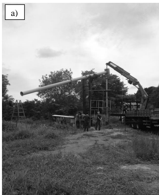
Figura 3.15 – Basculamento do tubo central. a) Basculamento; b) Leitura dos extensômetros.
