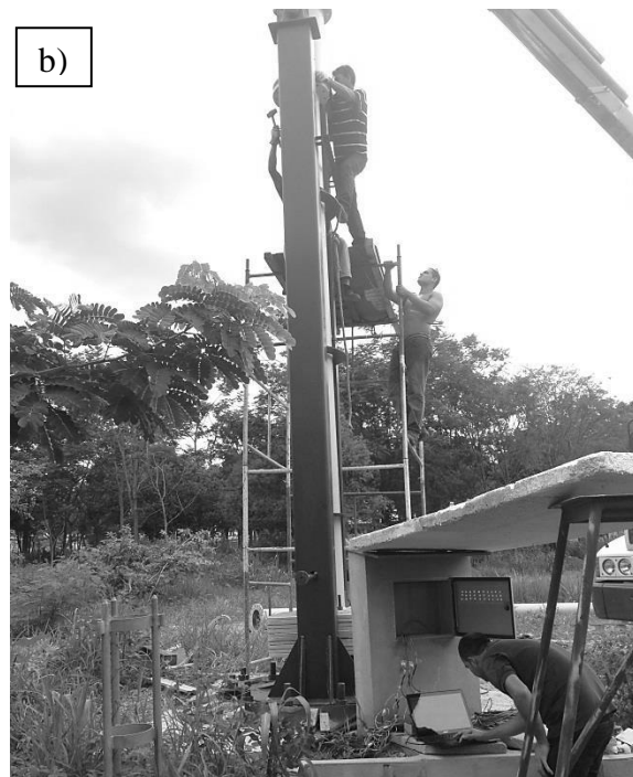
Figura 3.14 – Instalação do tubo central. a) Içamento; b) Leitura dos extensômetros.
