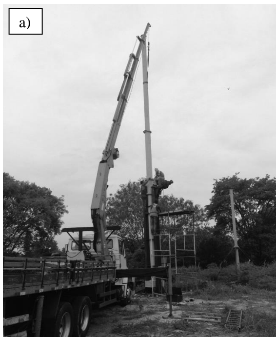
Figura 3.14 – Instalação do tubo central. a) Içamento; b) Leitura dos extensômetros.
