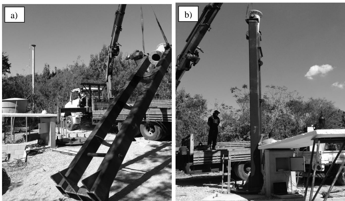
Figura 3.13 – Instalação da base de suporte da torre. a) Içamento; b) Leitura dos extensômetros.
