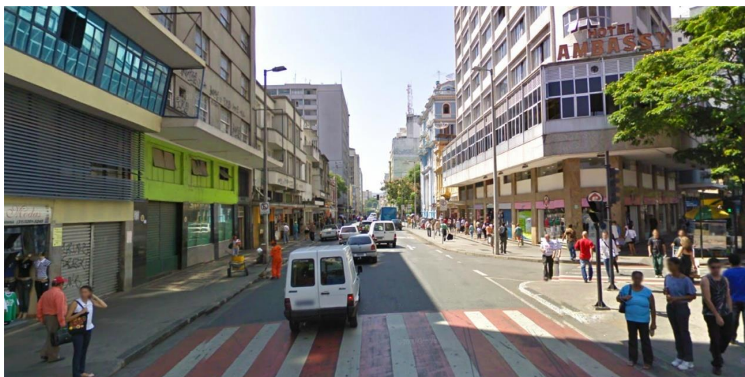
Figura 5.3: Rua dos Caetés no Hipercentro de Belo Horizonte Fonte: Google Streetview
