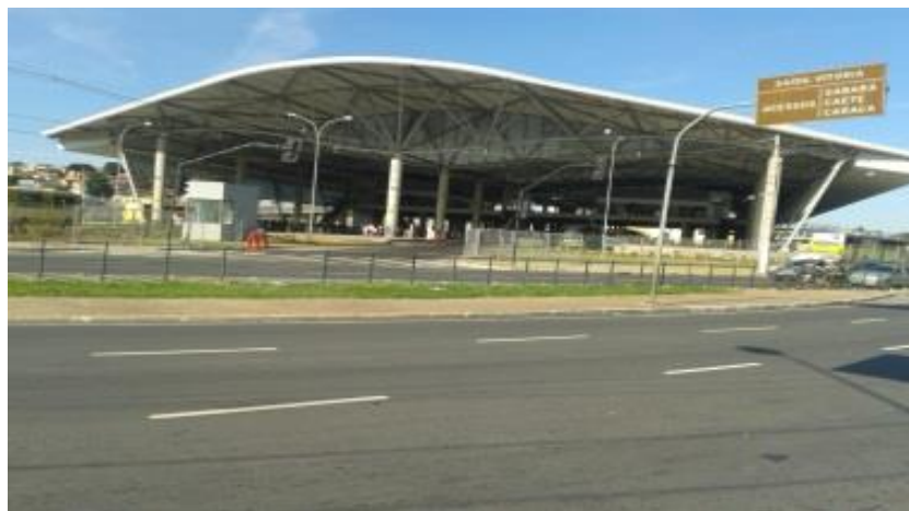
Figura 1 – Vista da Estação São Gabriel a partir da Av. Cristiano Machado (2014)
