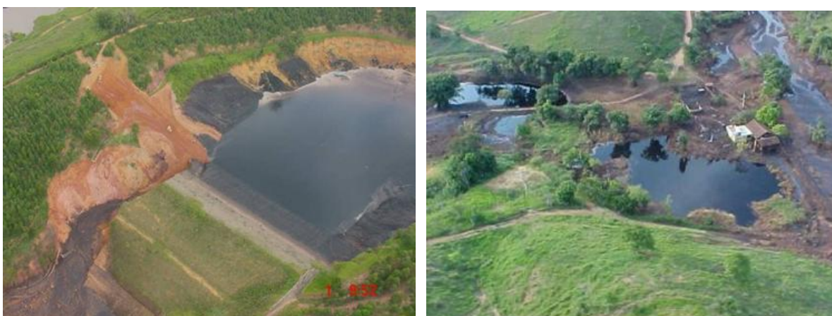
Figura 2.16: Imagem aérea da barragem de Cataguases e do ribeirão do Cágado, após a ruptura. Fonte: Vianna, 2012.
