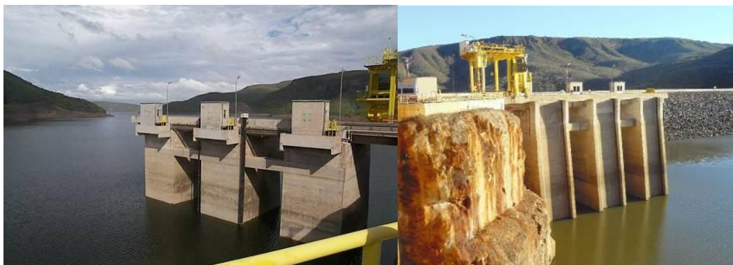
Figura 3.14: Vista de jusante e montante das 3 torres da tomada d'água. Fonte: CEMIG, 2012
