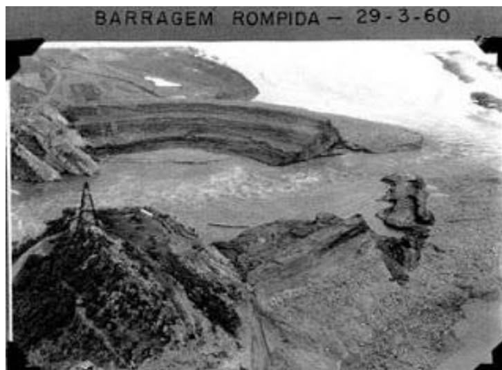
Figura 2.11: Rompimento da barragem de Orós. Fonte: Maestri, 2012
