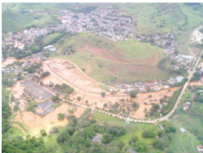
Figura 2.19: Vista da área inundada em Mirai Fonte: Menescal, 2007.
