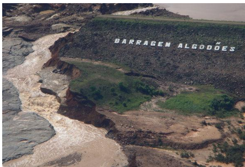
Figura 2.20: Rompimento da barragem de Algodões I. Fonte: Portal de notícias 180 Graus, 2009.
