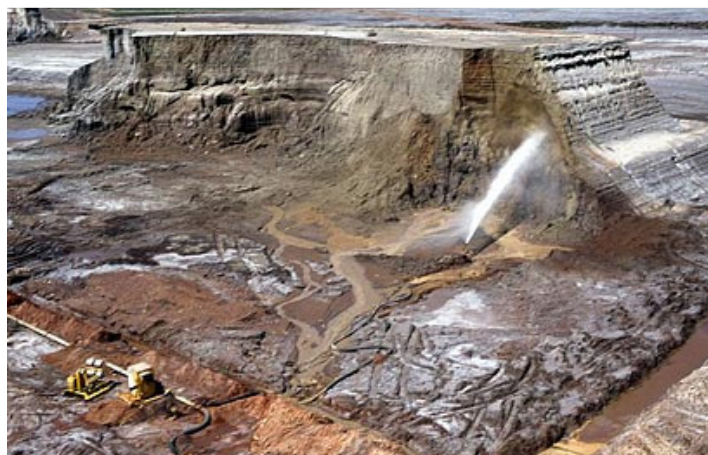
Figura 3.29 – Desmonte hidráulico pela face em Kalgoorlie, Western Australia (TAILINGS.INFO, 2014).
