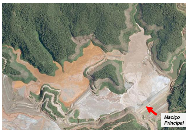
Figura 3.10 – Barragem do Fundão – Samarco Mineração S.A. (REZENDE, 2013).
