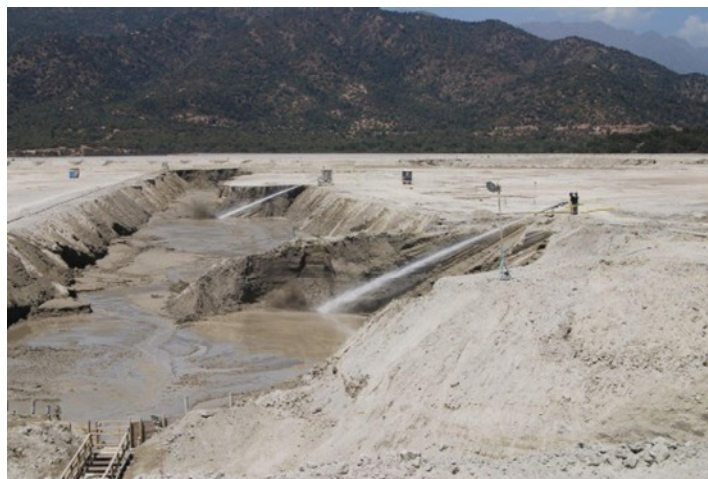
Figura 3.30 – Desmonte hidráulico por bancada em operações da Minera Valle Central (MVC, 2015).
