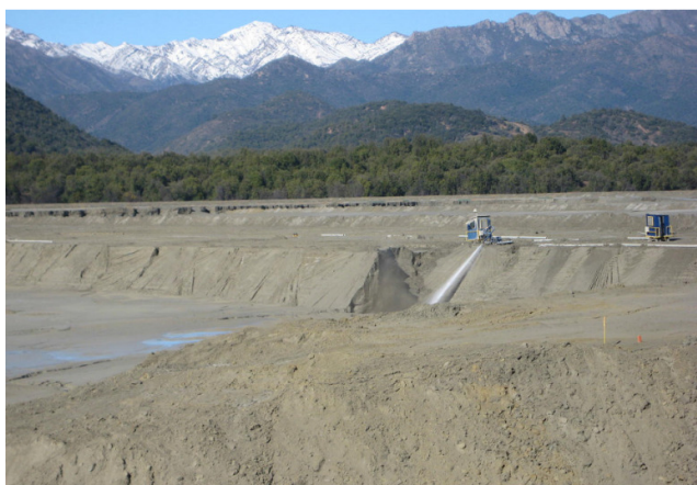
Figura 3.25 – Desmorte hidráulico na Barragem da Mina El Teniente, Chile (PIGNATON, 2010)
