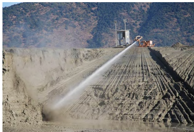
Figura 3.33 – Desmonte hidráulico na Barragem Colihues (HENDERSON, 2013).
