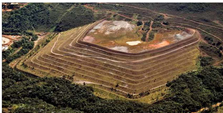
Figura 3.2 – Empilhamento Drenado do Xingu (GOMES, 2009b).
