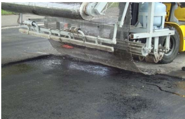
(a) colocação da geogrelha
