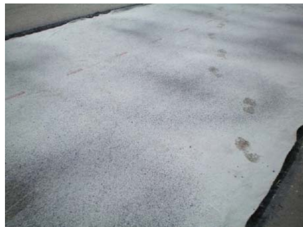
(b) geotêxtil instalado, com pintura de ligação superficial
