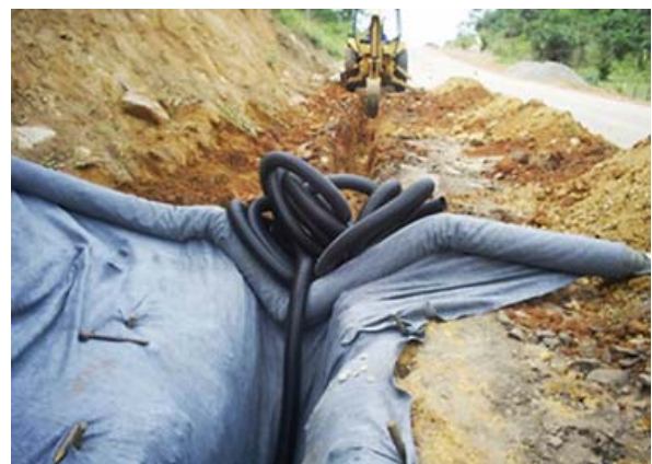
(f) geotubos ( www.kanaflex.com.br , 2015)
