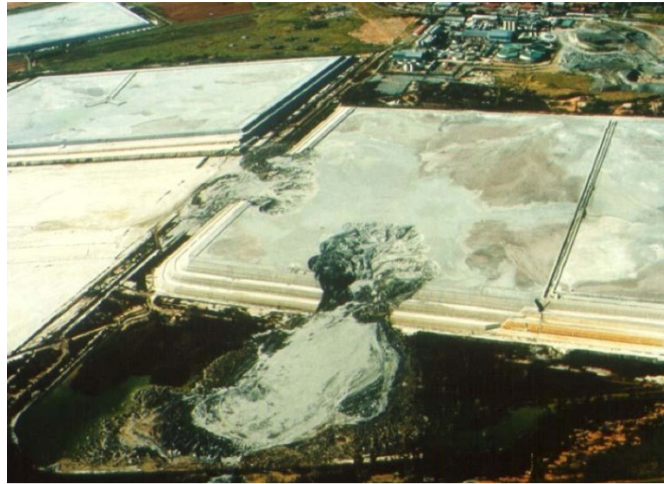
Figura C22 - Vista aérea da ruptura da barragem Saaiplaas (BLIGHT, 2010)
