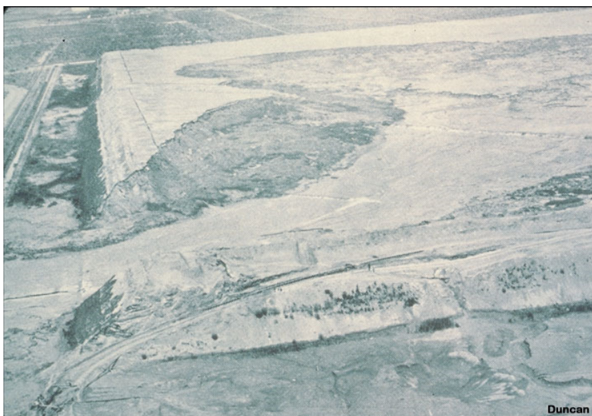
FiguraC9 – Vista aérea da ruptura de Bafokeng.
