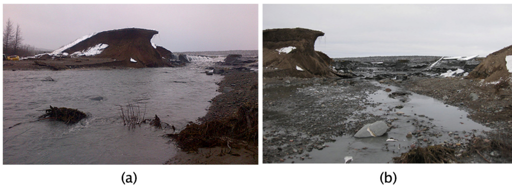
Figura C41 – Brecha formada na ruptura. a) durante a ruptura, no dia 17/12/2012, b) após a estabilização, no dia 18/12/2012.
