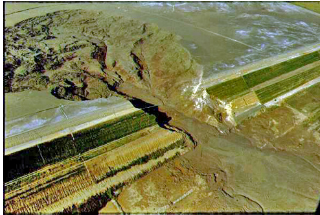
Figura 2.35 - Imagem aérea da ruptura da barragem de Merriespruit (TAILINGS.INFO, 2015)
