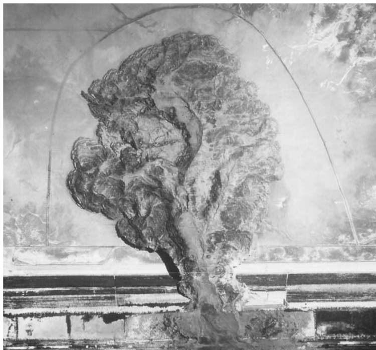
Figura C24– Vista aérea da brecha aberta e do reservatório rompido (BLIGHT, 2010)
