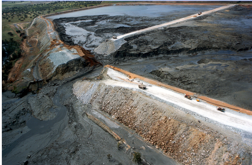
Figura C31–Vista lateral da brecha formada
