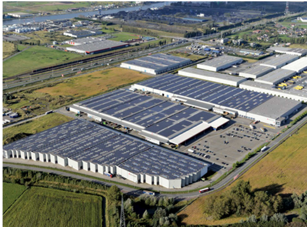
Figura 4.12: Instalações utilizando painéis fotovoltaicos
