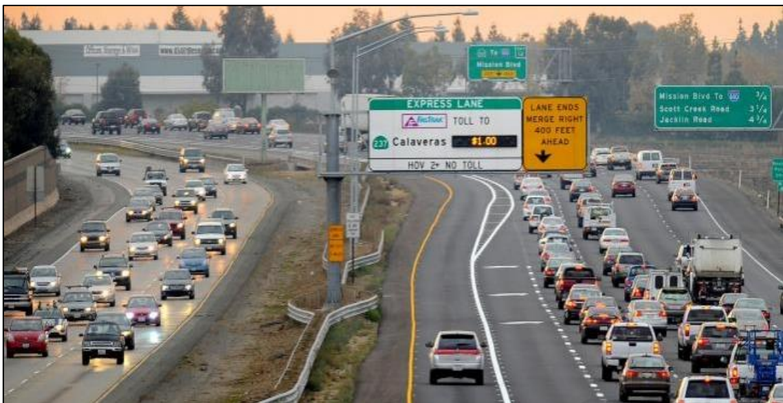
Figura 2.2 – HOV e HOT lanes, Via Expressa I-680 em São Francisco (Estados Unidos) Fonte: Metropolitan Transportation Commission (MTC, 2016)
